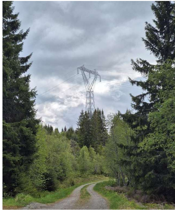
Figur 5-13 Eksisterende 300 kv mast ved Seimsfjellet.
