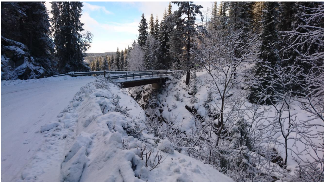
Figur 5. Bru nedstrøms Vågi dam.
