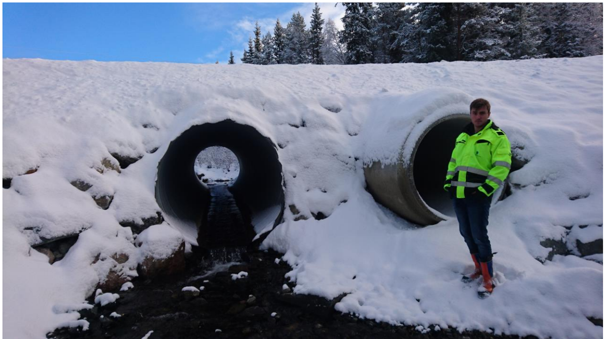
Figur 3. Kulverter ved Sveivhylen
