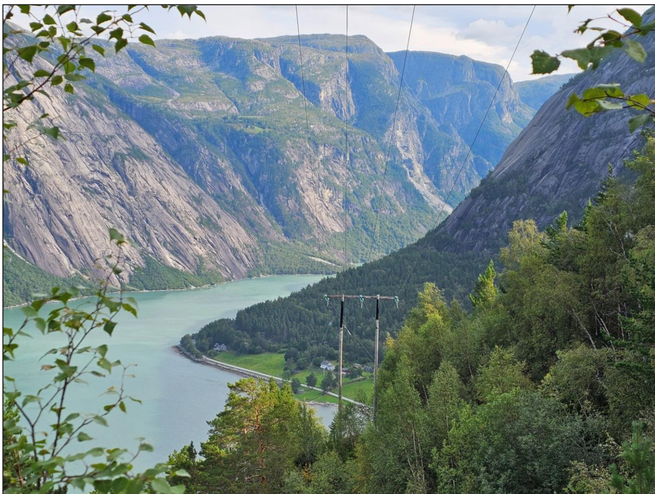
Figur 3-3: Eksisterende 50 kV ledning som skal erstattes med ny 132 kV ledning. Foto: M. Bjerga, Multiconsult.
