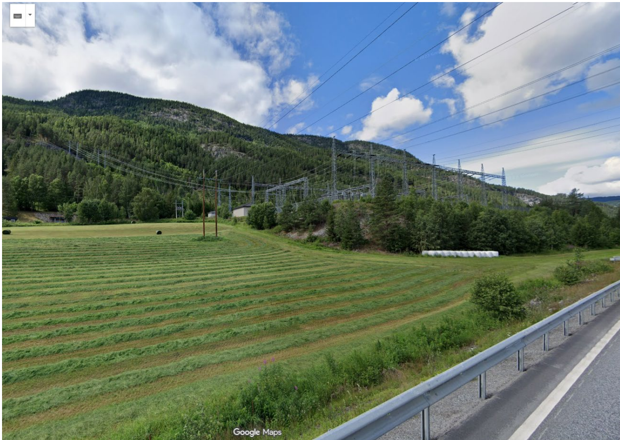
Figur 5: Bilde fra riksvei 7 (Google Maps Street view, juli 2023). Eksisterende luftspenn fra kabeltunnel (i venstre del av bildet), vil saneres. Det er gjennomført mer hogst i området etter dette bildet ble tatt.
