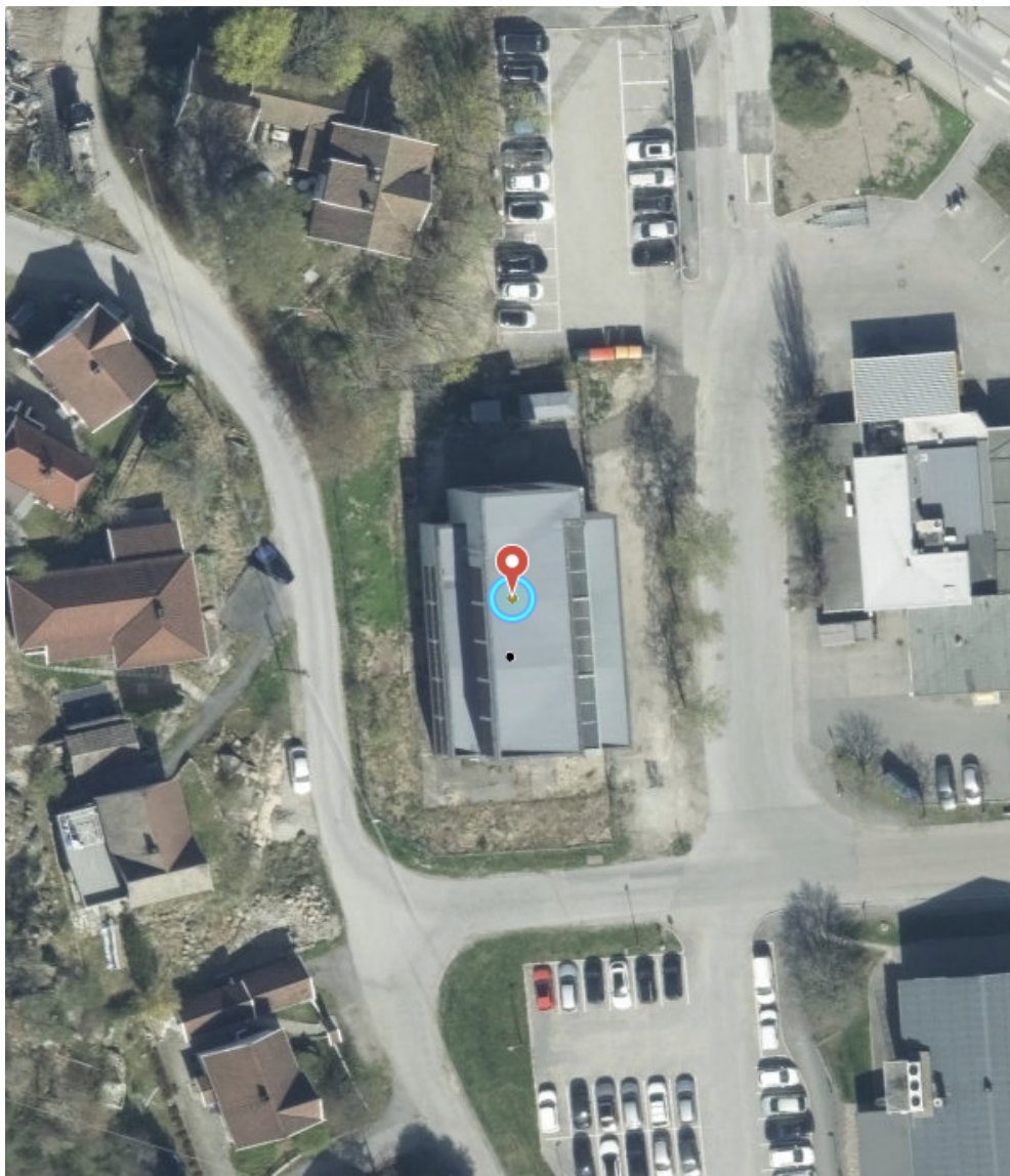
Figur 4 Ortofoto av Kråkerøy transformatorstasjon og randsonen. Kilde: NVE, 2025.
