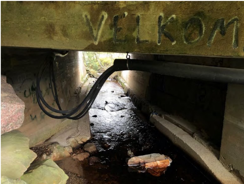
Figur 6. Gjennomløp av bru Setesdalsvegen. Sett fra oppstrøms side.
