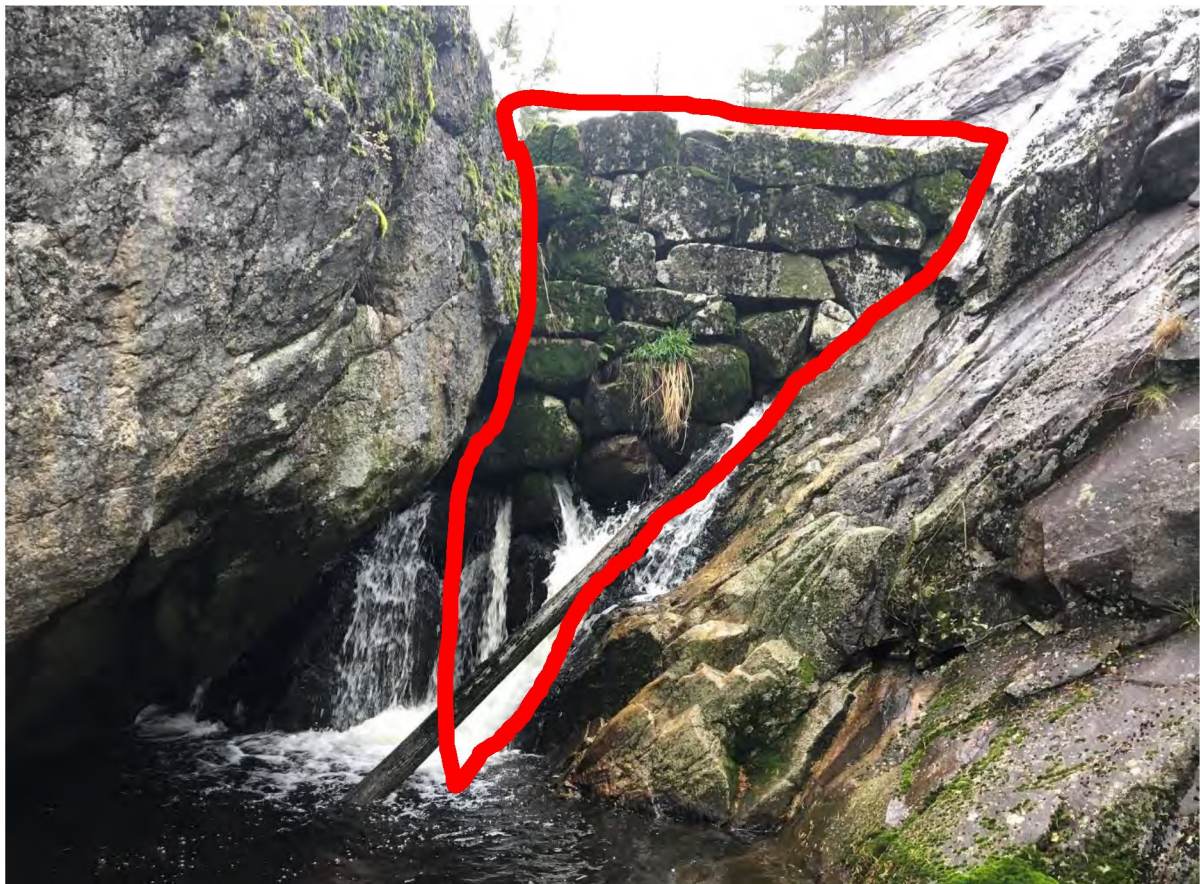
Figur 41. Bilde av stem sett fra nedstrøms side. Rød strek viser omtrentlig hva som ble fjernet i tverrprofilet.
