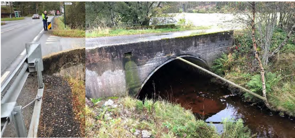
Figur 4. Bru Setesdalsvegen til 781-787. Sett fra oppstrøms side.
