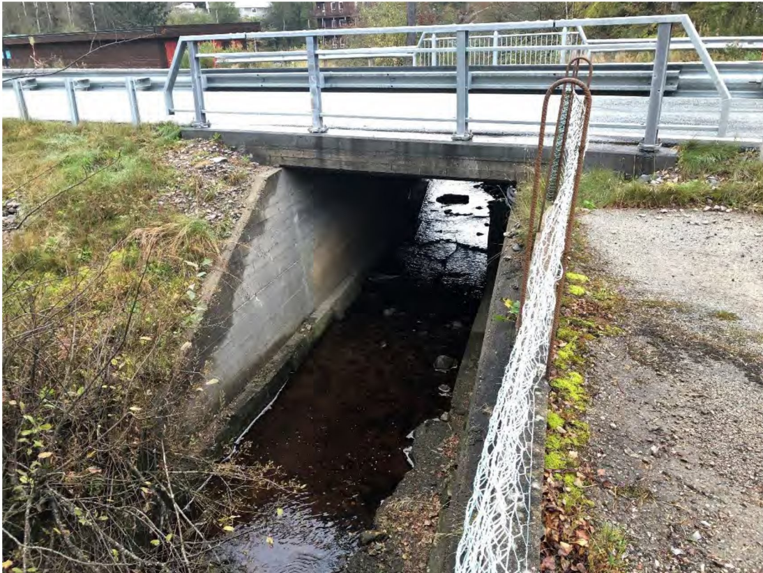
Figur 7. Bru Setesdalsvegen sett fra nedstrøms side.
