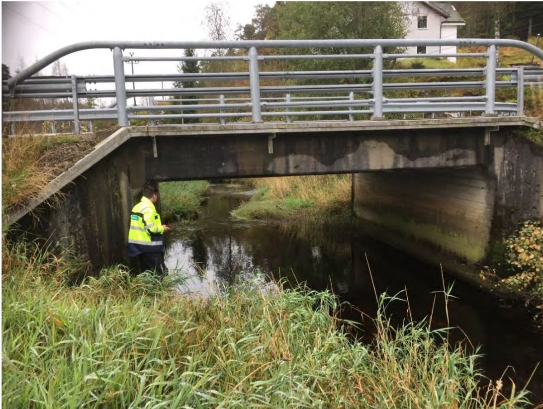
Figur 9. Bru ved Stallemovegen tatt fra oppstrøms side.
