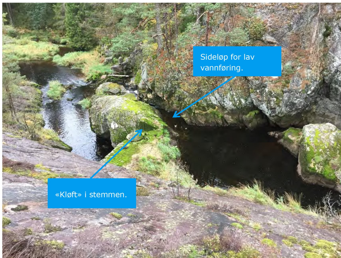
Figur 15. Stem sett fra oppstrøms side.
