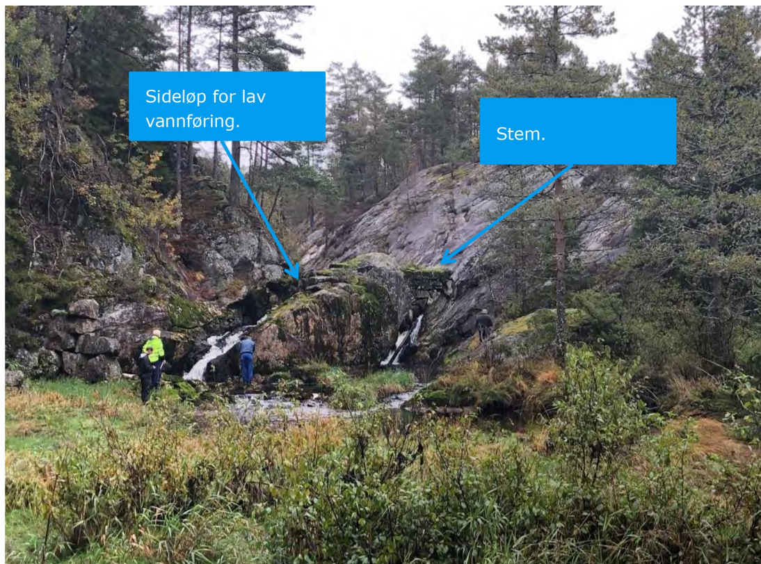
Figur 18. Oversiktsbilde av stemmen sett fra nedstrøms side. Sideløp til venstre og stem til høyre.
