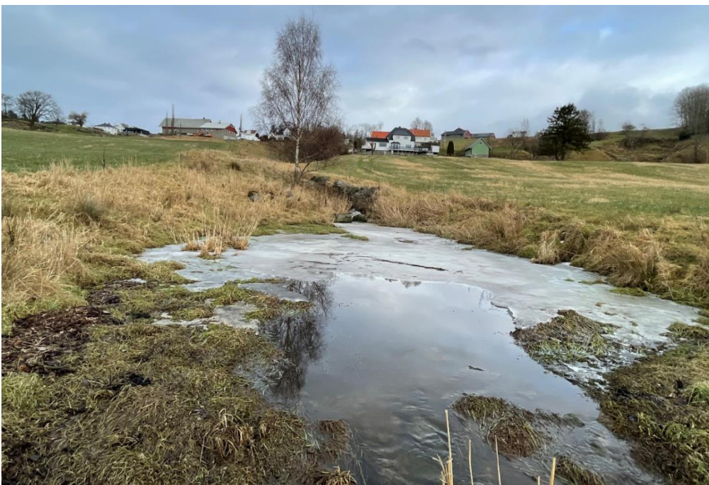
Figur 21 Utløpet av bekken er demmet opp av plastring/steinfylling i bunn, grunneier sier de tømmer denne demningen jevnlig og legger ut massene på siden, 19.02.2021
