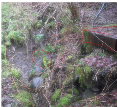
2014 (befaring med SVV). Markert antatt plassering rør lagt i 2018 og brønn
