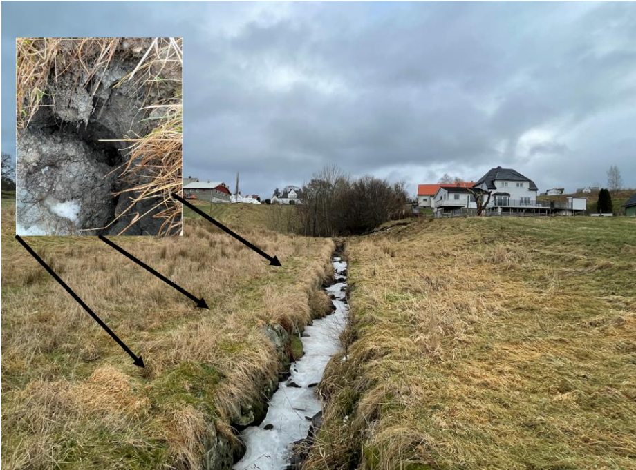
Figur 20 Bunn av bekken/ravinen er det utført plastring i form av etablert en rett kanal, 19.02.2021
