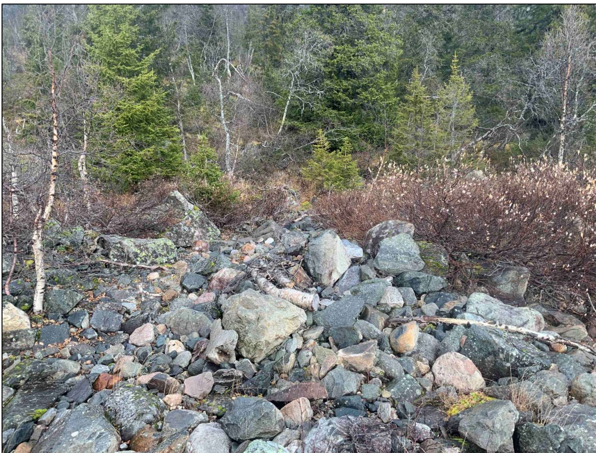
Figur 3. Bildet fra lokaliteten med åpen flomfastmark nedstrøms damanlegget.
