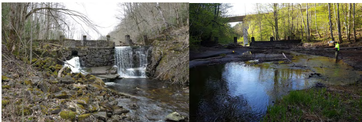
Figur 1: Bjørumdammen sett nedenfra og fra oppstrøms side. (Foto fra søknaden.)
