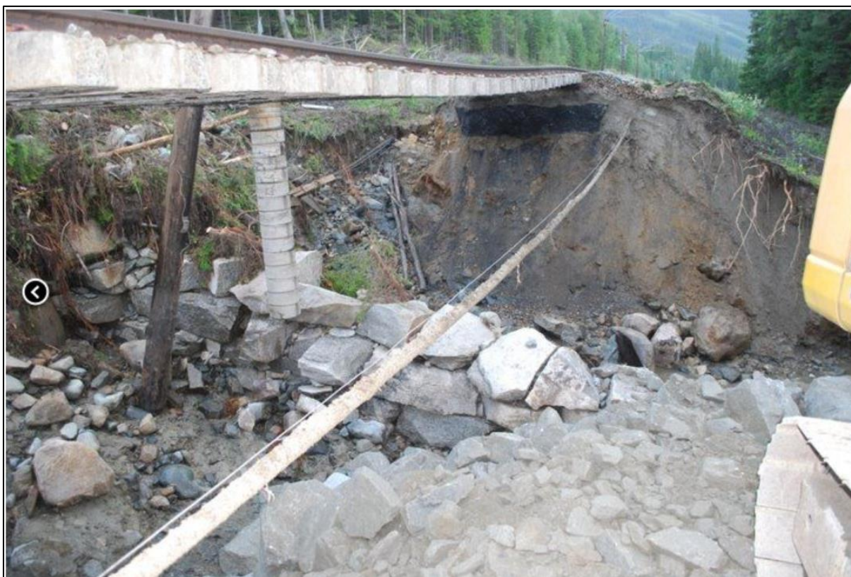
Figur 6: Bildet er tatt i forbindelse med intens nedbør i 2011 som førte til at jernbanefylling raste ut. Bildet er hentet fra hjemmesiden til Oddvar Øygard AS (Oddvar Øygard AS, 2011).
