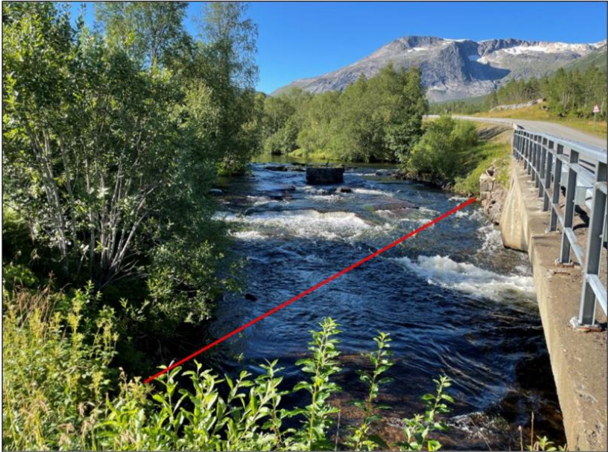
Figur 4: Dagens situasjon. Rød strek markerer posisjon for planlagt terskel. Inntak vil ligge i nedre venstre hjørne. Kilde: Konsesjonssøknad, Hywer AS.
