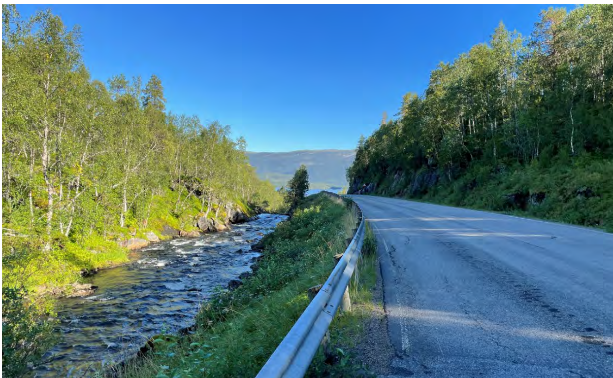
Bilde 6: Nedover planlagt rørgatetrase, cirka ved pel 550
