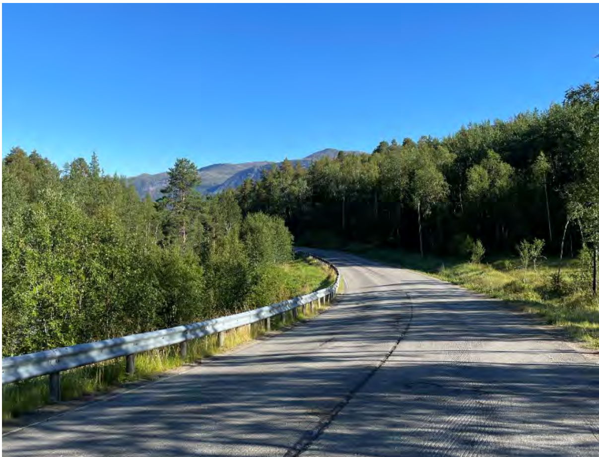
Bilde 5: Nedover planlagt rørgatetrase, cirka ved pel 650
