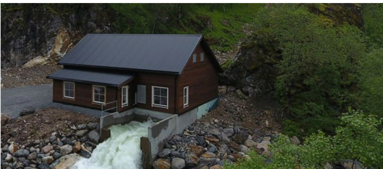
Figur 20 Typisk Francis kraftstasjonsbygning designet av Hywer (foto fra Grytendal kraftverk)
