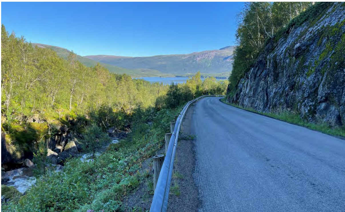
Bilde 7: Nedover planlagt rørgatetrase, cirka pel 300, rørgatetrase forlater veitrase fra pel 250. Avkjøring til permanent adkomstvei til kraftstasjon ved pel 250.
