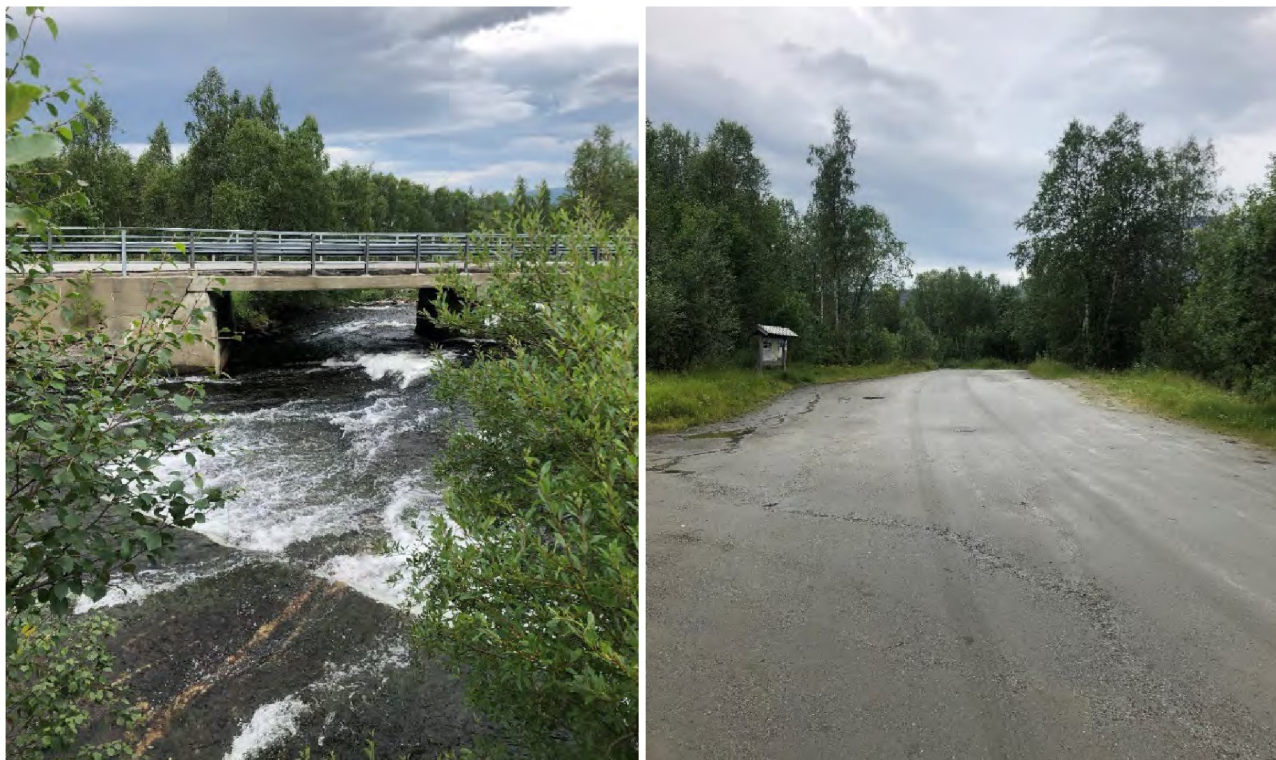
Figur 4-1: Venstre = Isak Sellanraas krysser Femtevassella like nedstrøms planlagt inntakssted. Høyre = Ved brua som krysser elva går det en traktorvei/grusvei langs Femtevassella til Sjettevatnet. Foto: Sweco
