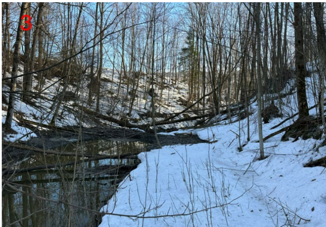
Figur 15. Bilde nr. 3 tatt under befaring. Viser området i bunnen av ravedalen nord for gården. Falne trær og synlig leire i skråningen.
