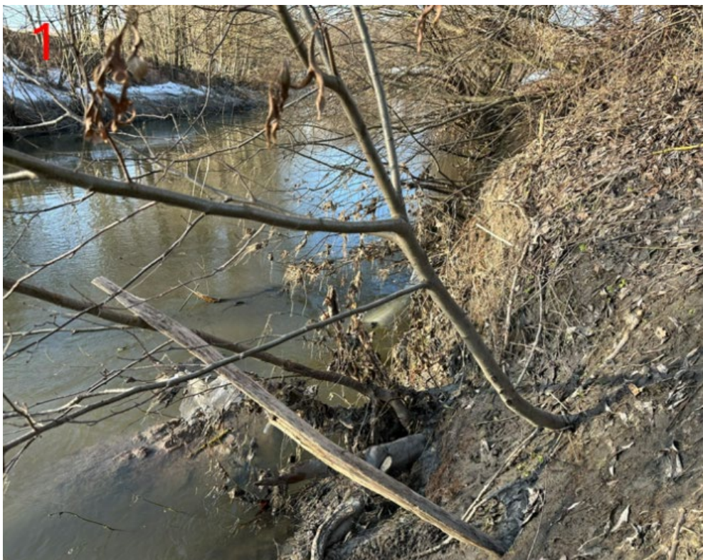
Figur 13. Bilde nr. 1 tatt under befaring. Viser pågående erosjon i elvekant mot sør.
