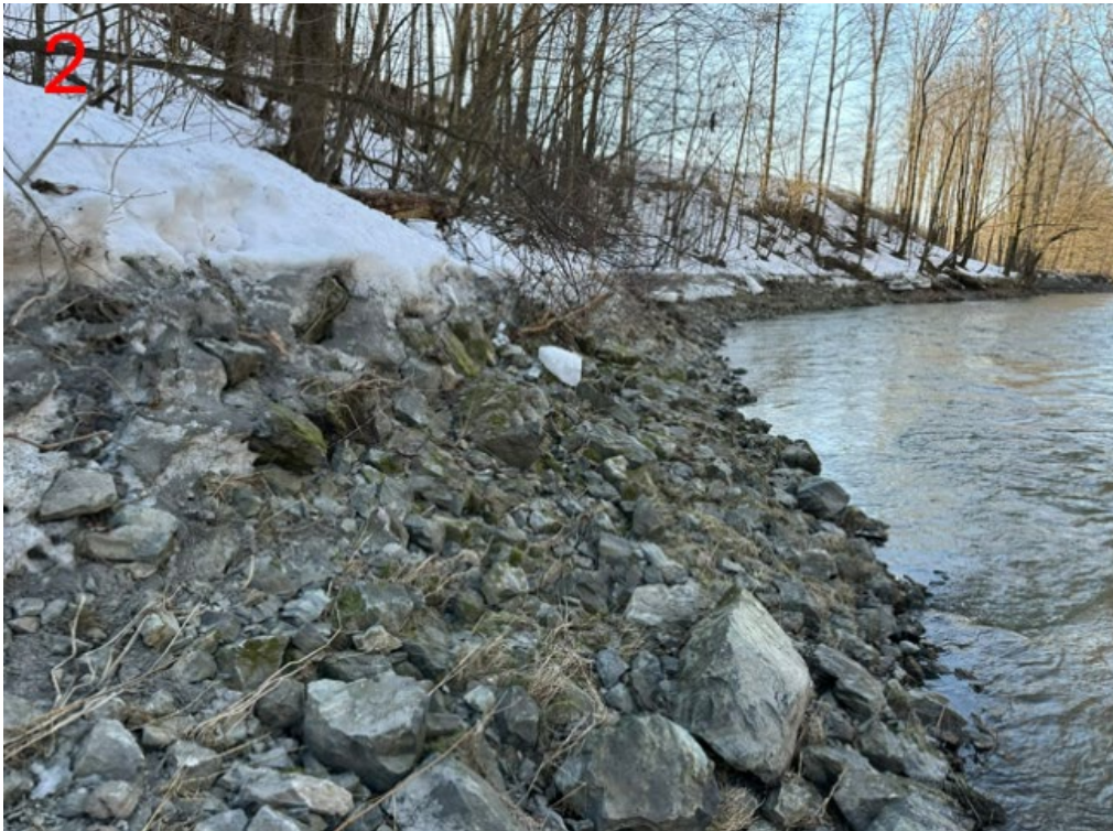
Figur 14. Bilde nr. 2 tatt under befaring. Viser erosjonssikring mot vest.
