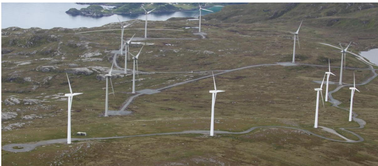
Figur 9 Bildet er fra 2013 og viser Mehuken 1 og 2. Mehuken 1 er nærmest med turbin 1.4 i midten, hvor testturbinen skal monteres.
