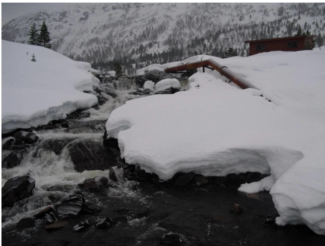
Bilete 2: Hevert ved vinterlege forhold. Is og snø fører til at heverten flytter på seg
