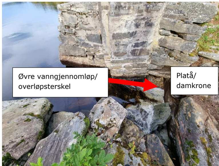
Figur 6: Øvre vanngjennomløp sett fra sørsiden
