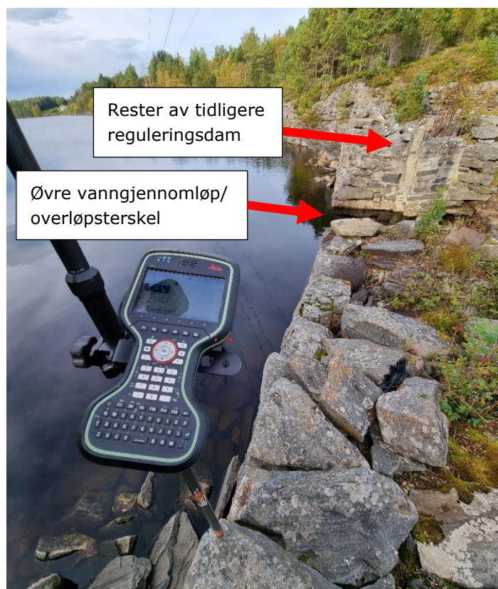
Figur 5: Eksisterende dam sett fra sørsiden av utløpet
