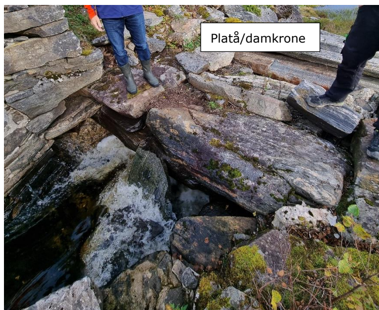
Figur 7: Øvre vanngjennomløp med platå/damkrone
