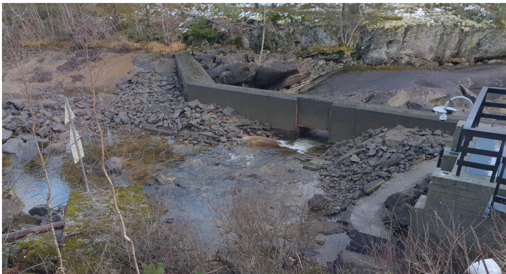
Foto nr. 2. Eksisterande betongdam ved inntak.
