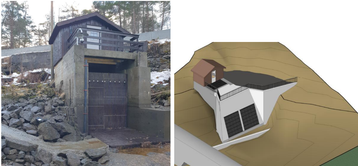
Foto nr. 1. Eksisterande inntak og lukehus og illustrasjon av oppgradert inntak .
