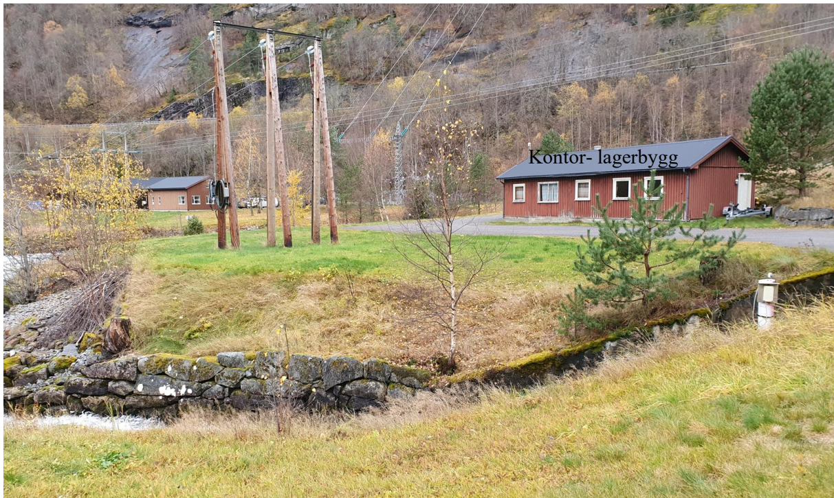
Foto nr. 4. Tomt for ny kraftstasjon der endemast for 22 kV-linje er plassert.
