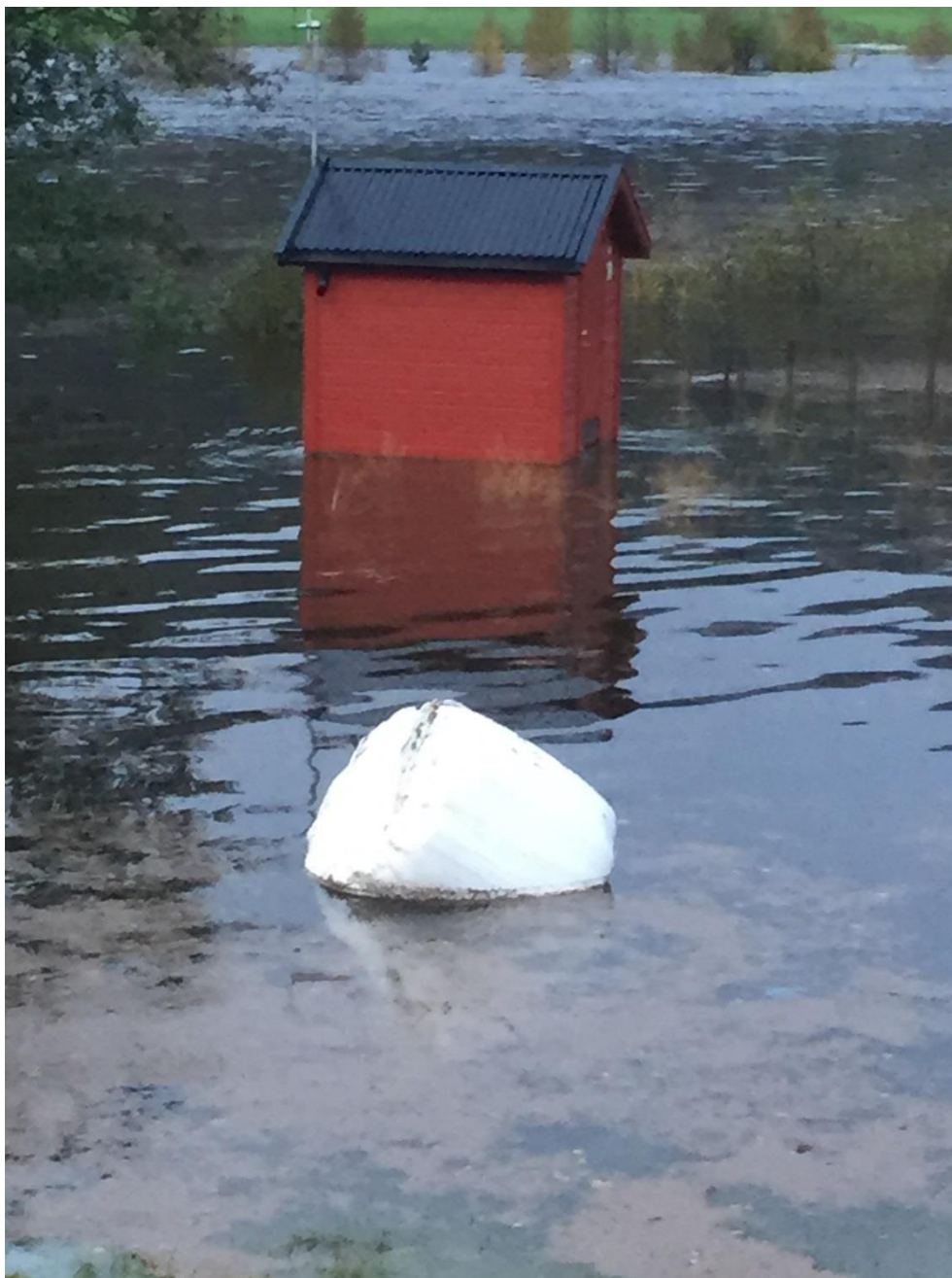
Figur 6 Flomvannstand i 2017 ved pumpehus Kaddeberg.
