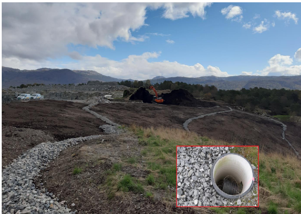
Figur 15: Bildet viser opparbeidede dreneringskanaler på deponiet ved Toraneset.
