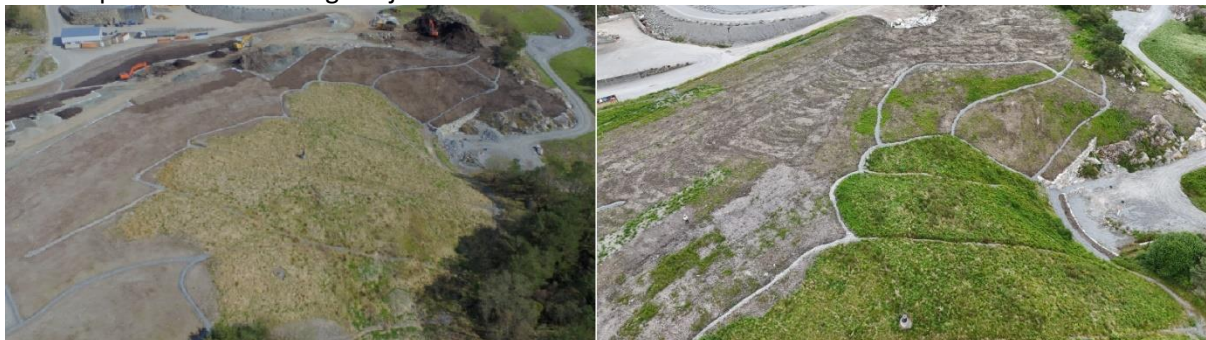
Figur 4: Venstre bilde viser arbeid utført for å legge det øverste organiske laget under befaringen i april 2024. Høyre bilde viser topplagsarbeidet ferdigstilt i juni 2024.
