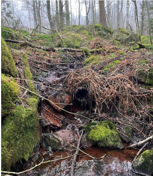
Figur 3-1 Bildet viser utløpet av vannledningen fra Ommundsvatnet til Skadbergvatnet, slik den ligger i dag.
