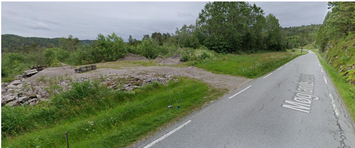
Figur 4-12 Riggområde langs Møglandsveien. (Kilde: Google Streetview)
