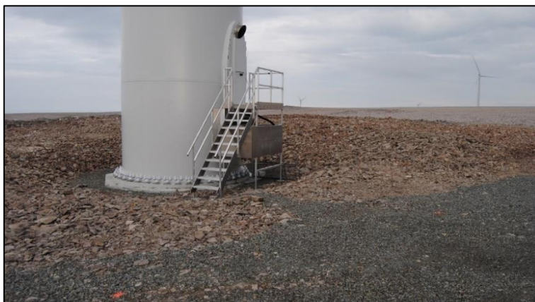
Figur 3-2. Turbinfundament og tårn i Raggovidda vindkraftverk etter tilbakefylling av masse. Foto: Multiconsult Norge AS.
