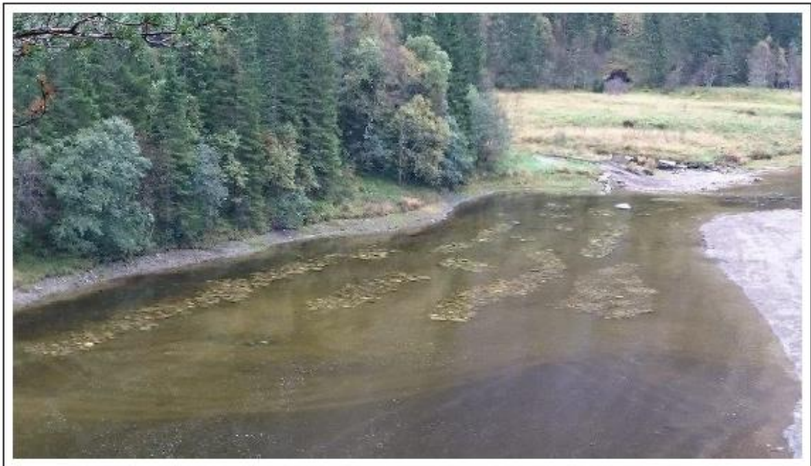
Figur 12. Eksempel på langsgående steinrekker for å øke skjulmulighetene for ungfisk. Bildet er fra steinrekker utlagt i Ekso, Hordaland der formålet var å øke fiskeproduksjonen.
