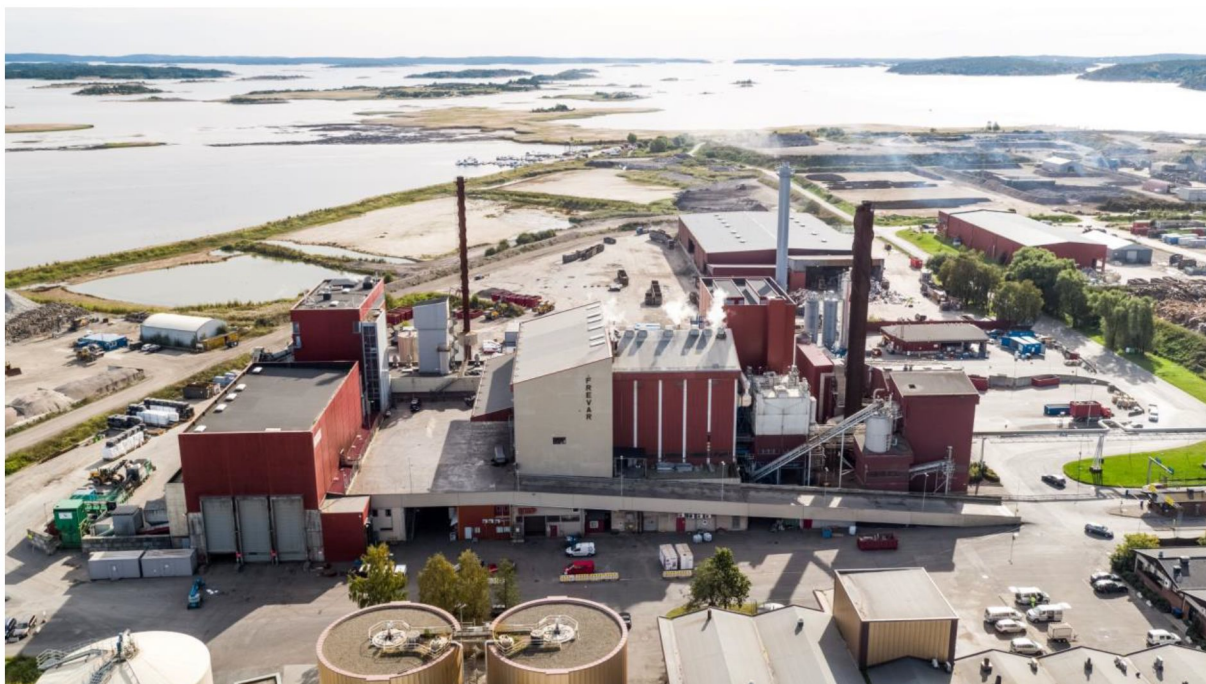
Figur 3 FREVAR sett fra nord mot syd. Bilde er tatt 17.09.2020.
