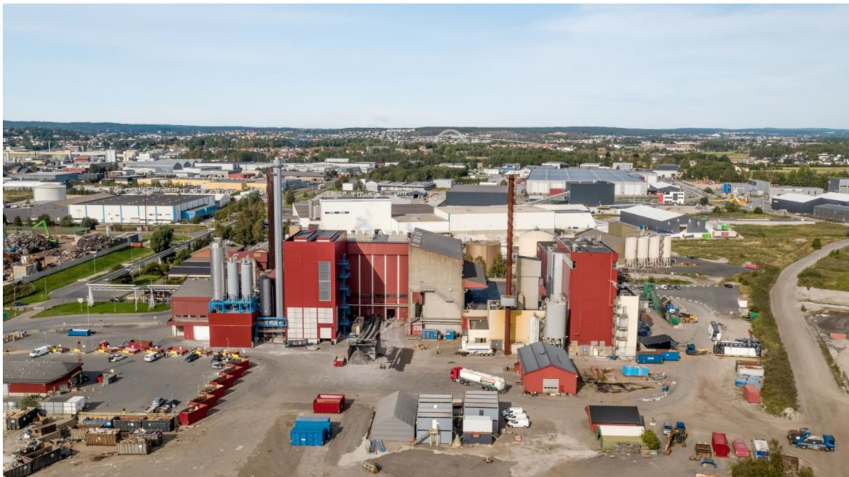
Figur 8 FREVAR fra syd mot nord. Med nytt røkgassrenseanlegg. Bilde er tatt 17.09.2020.
