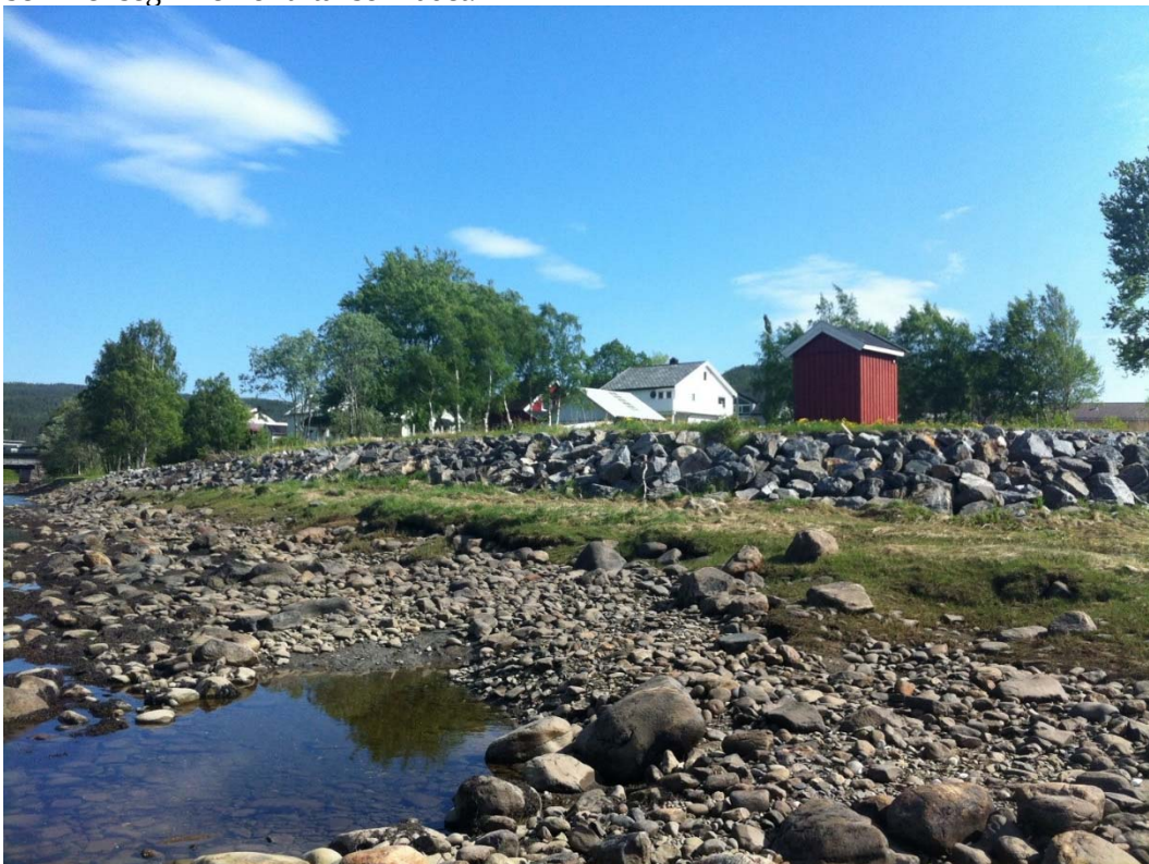
Figur 2: Norddalselvas venstre bredd. Avslutning av sikring.
