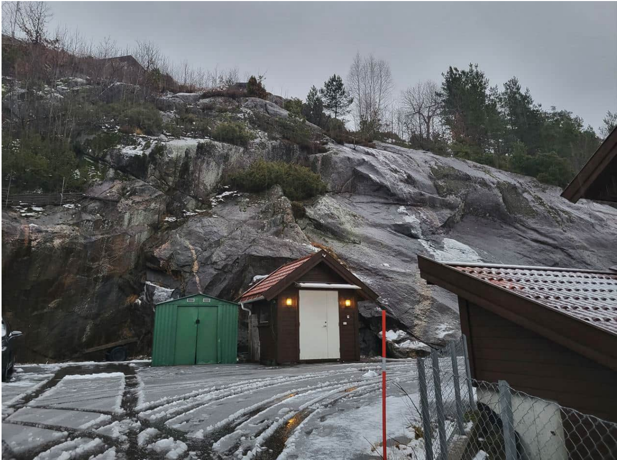
Figur 14: Skråningen hvor det kan forventes mindre utglidninger i våtsnøpakken, foto Rambøll.
