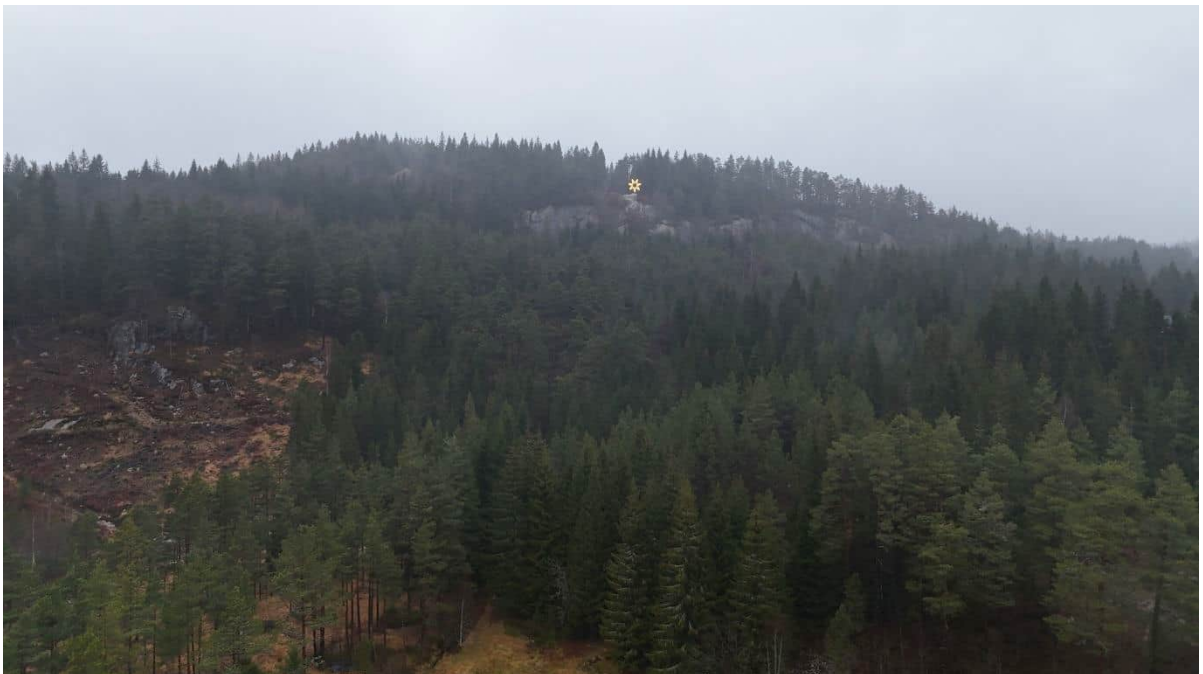
Figur 21: Dronebilde av Rambøll som vise potensielle løснеområder under Brurefjell. Ser mot nord.
