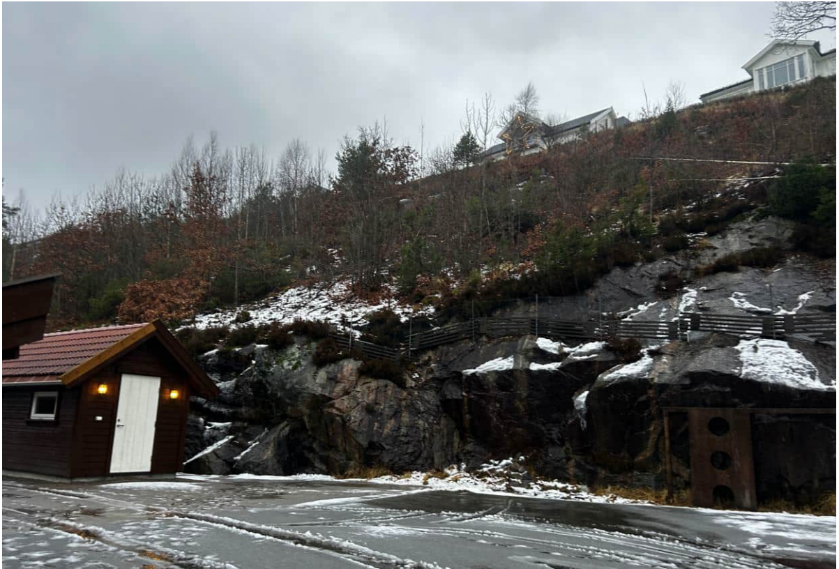
Figur 18: Skråning bak Nedre Solknipen 5 med tynt løsmassedekket over berg. Ser mot nord, foto Rambøll.
