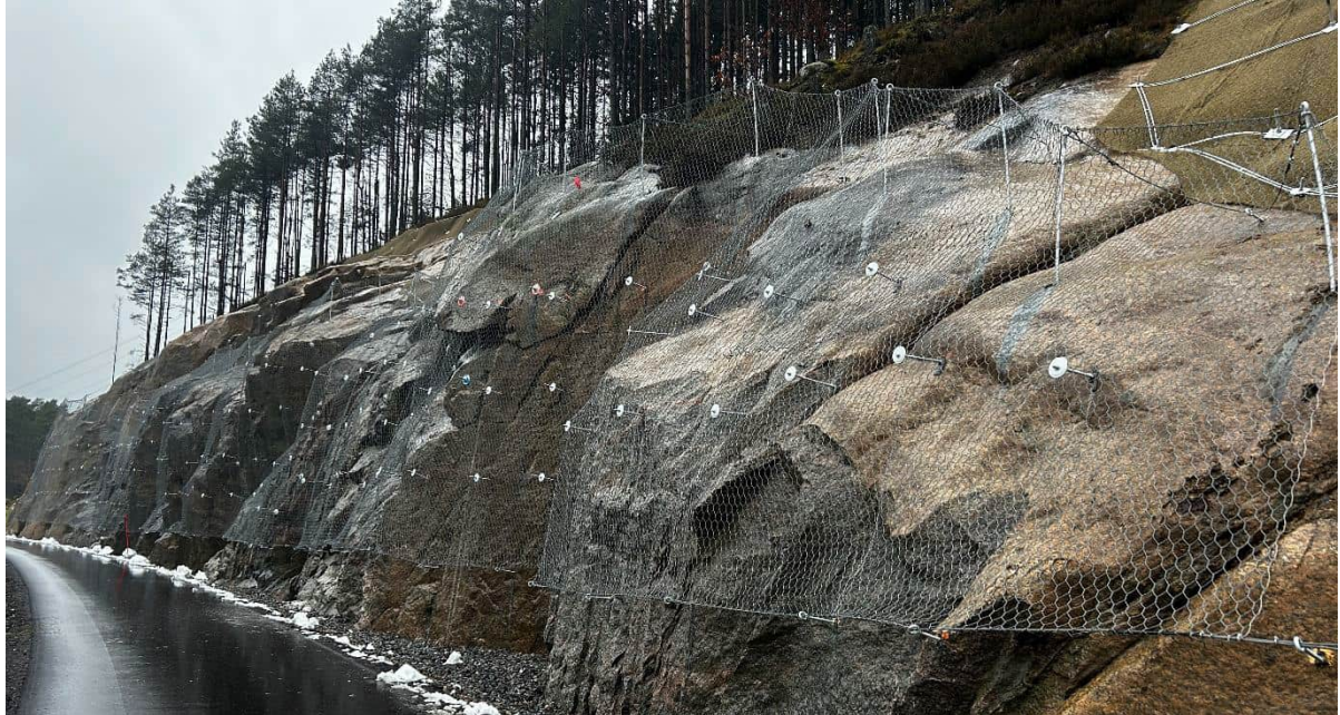
Figur 11: Eksisterende sikring langs Setedalsvegen, foto Rambøll.
