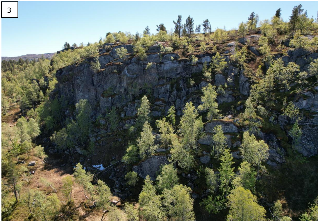
Figur 13. Oversiktsbilde over nordvestre del av området ved punkt 3. De høyeste partiene er opp mot 40 m høye. Hovedsprekkene faller innover mot skrenten slik at det dannes overheng. Terrenget ovenfor kanten i toppen er nær flatt.
