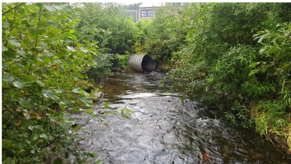
Figur 16: Nedenfor transformatorstasjonen møtes sidebekken og Storbekken og renner videre nedover til Tverråga
