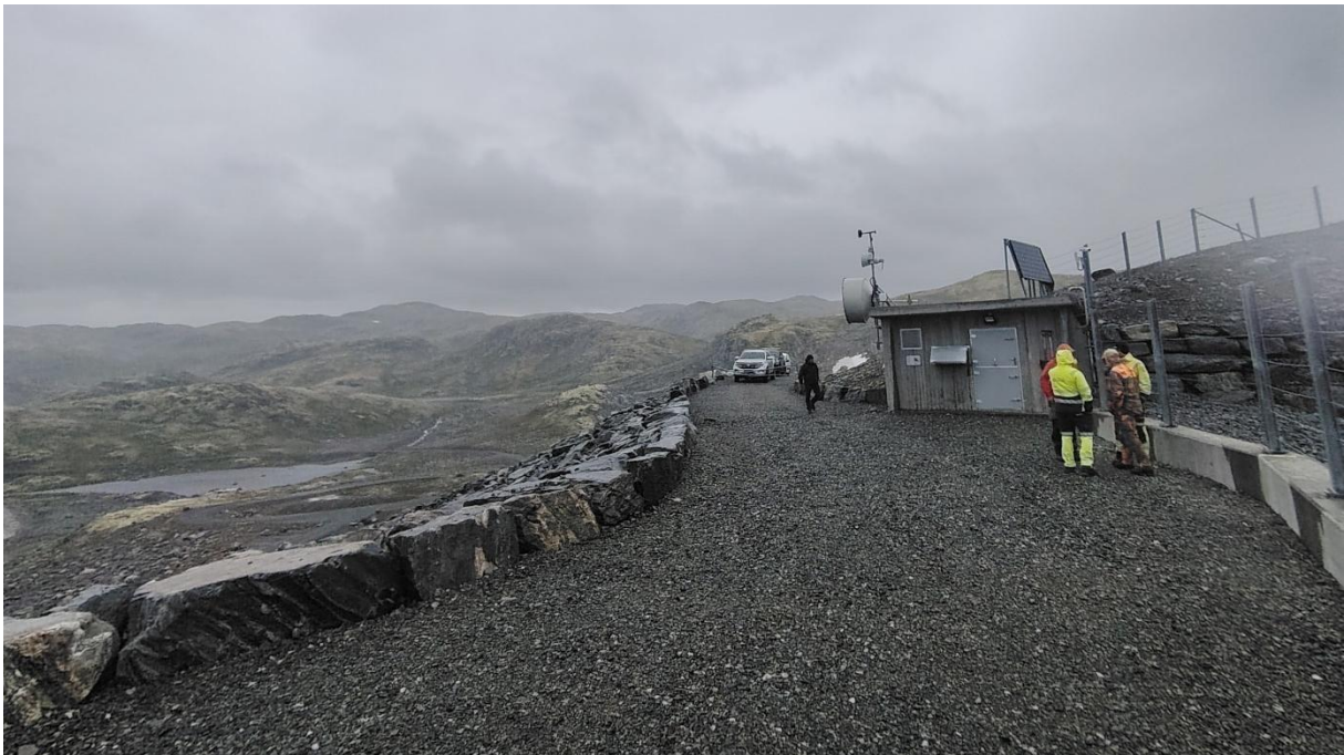
Figur 3-2 Befaring på damkrona ved Kvevatnet.
