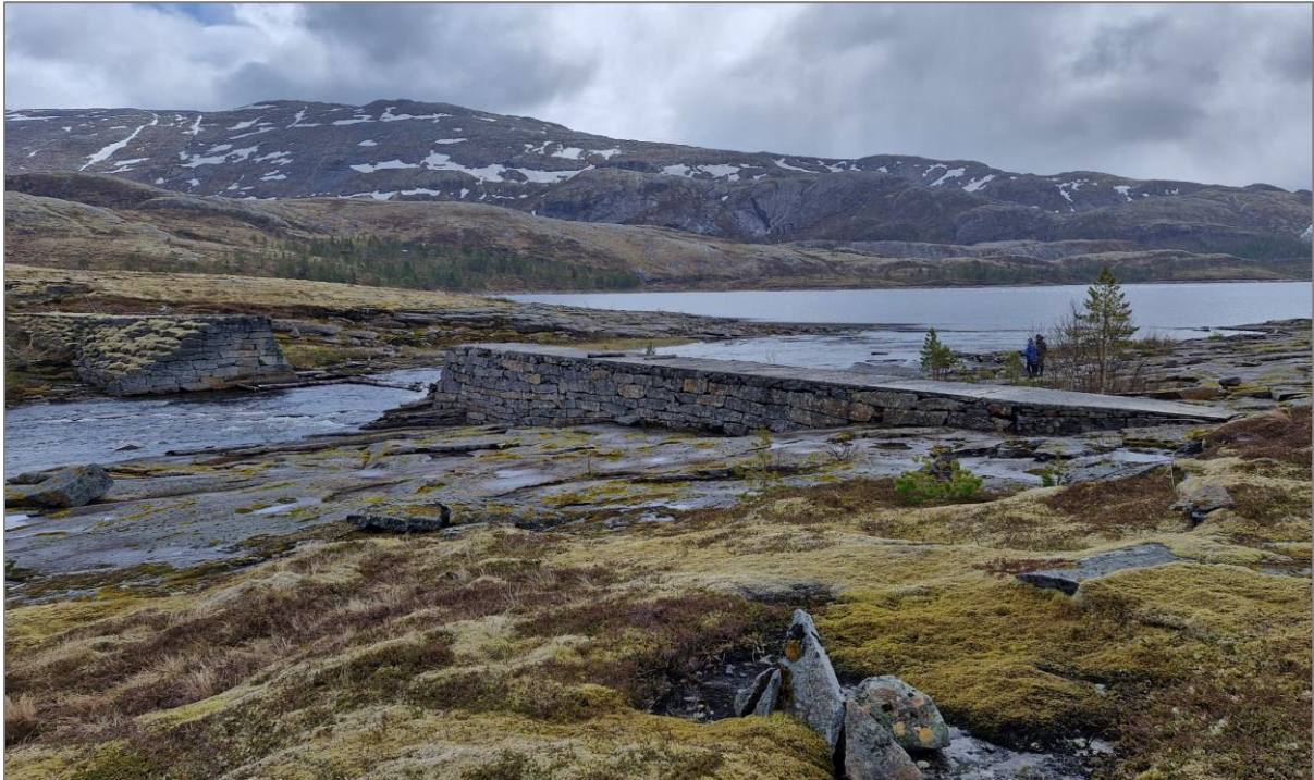
Figur 1–2. Eksisterende dam ved Mellavatnet på nedstrøms side. Foto: Sweco.
