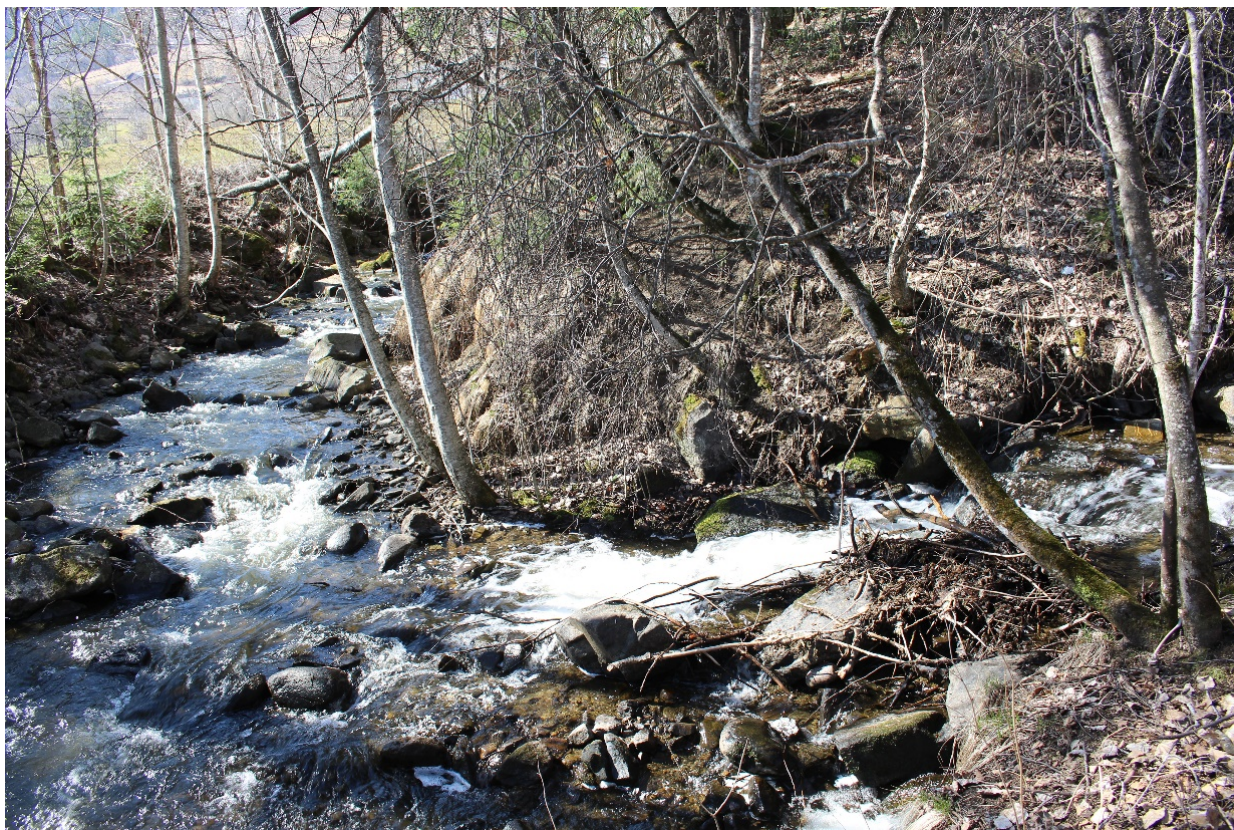
Raua ved samløp mellom elveløpet fra Rausjøen og avløpskanal fra Raua kraftverk (inn fra høyre på bildet). Vårsituasjon med middels lokaltilsig og 55 l/s i avløpskanalen, 22.4.2022
