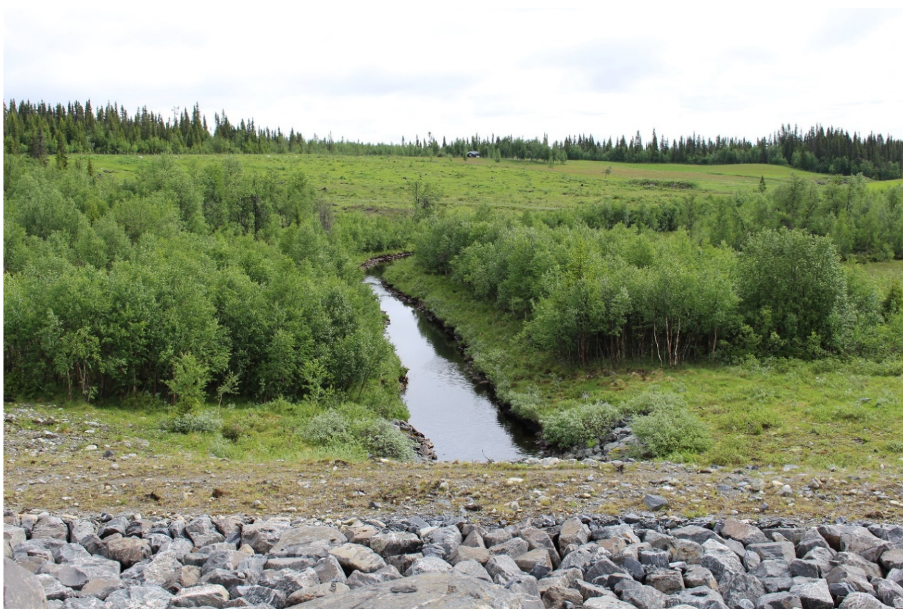
Kunstig kanal fra Ropptjern til inntak Roppa kraftverk, 22.6.2021
