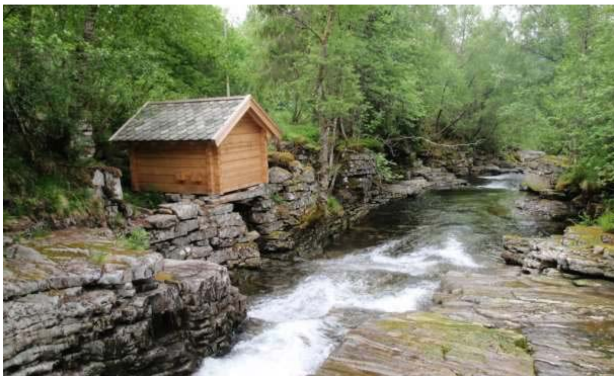
Figur 10. Her har ein av grunneigarane sett opp eit nytt kvernhus på gamle murar. Det som er teke vare på av det gamle er berre murane og akselen for kvernkallen. Elles var det fleire restar å sjå etter kverner her. Området ligg mellom brua som bind dei to sidene av dalen saman og ein større foss som er rekna som eit absolutt vandringshinder for anadrom fisk. Akkurat i dette området renn elva på fjellgrunn. Elles renn ho gjennom meir eller mindre grove lausmassar. (Foto; Geir Frode Langelo ©).
