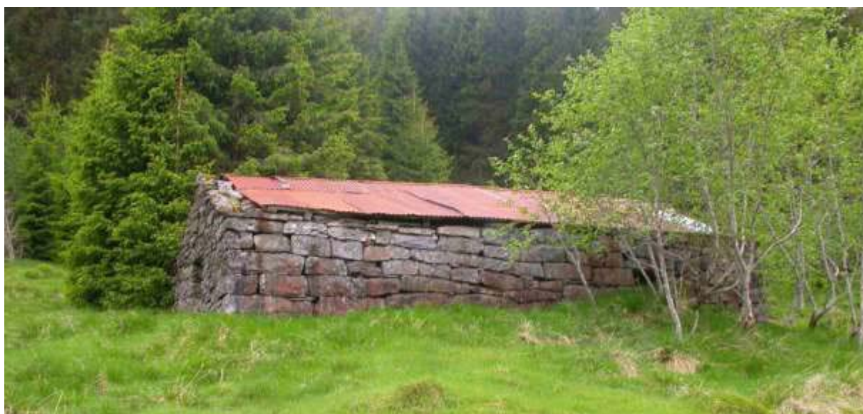
Figur 3. Det finst fleire slike mura fjøsbygningar i Stårheimsdalen, og når byggverket er utført som gråsteinsmur, så er det nok helst fordi høveleg trevrake var mangelvare i bygda tidlegare. Om vi ikkje har misforstått, så vart desse fjøsa nytta som eit slags sommarfjøs eller vårstøl. Alderen på fjøset er det knapt nokon som veit lenger, men det kan kanskje vera på sin plass å minna om at på ein annan stad i Sogn og Fjordane med historisk sus over seg, nemleg på Losna er det også gamle fjøsbygningar av stein i overgangen mellom innmark og utmark. (Foto; Finn Gunnar Oldervik ©).
