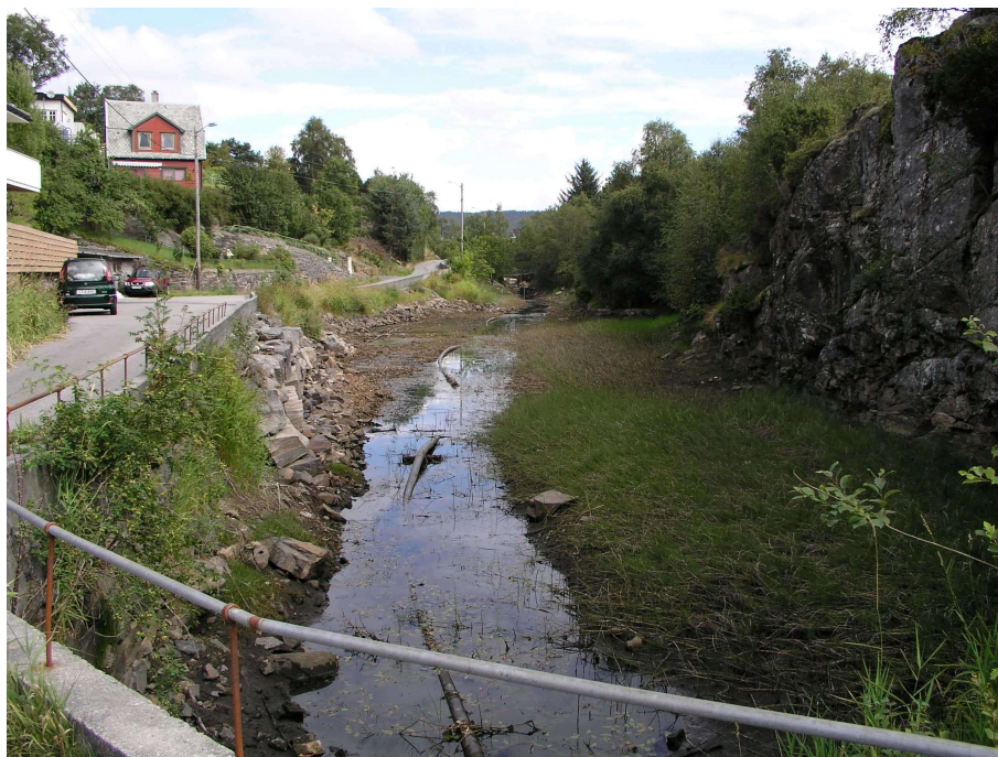
Foto tatt i august av kanalen. (motsatt vei av forrige foto)
