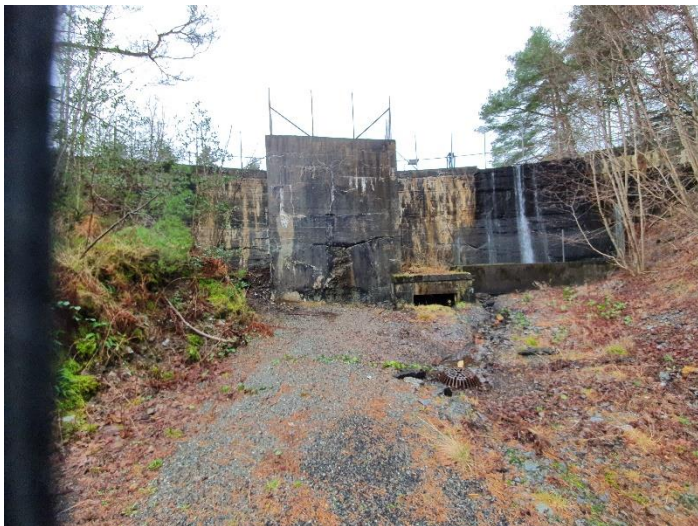
Dammen sett fra luftsiden
