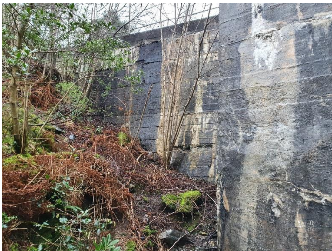
Luftsiden (høyre side)
