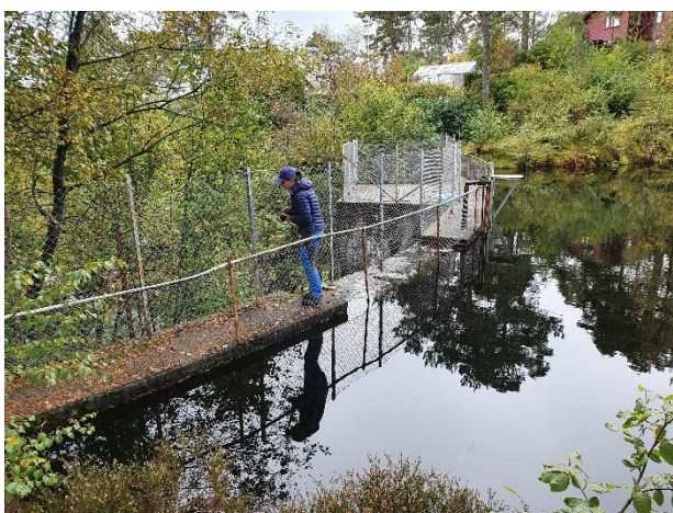
Dammen sett fra venstre side, en ser overløpet og silkammeret
