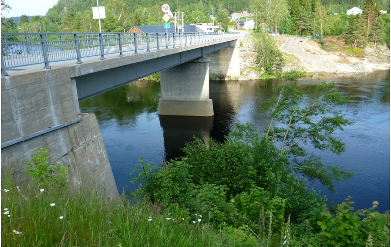
Figur 3.4 Boenfoss bru, sett fra høyre bredden i nedstrøms retning. Foto: J. Sauterleute
