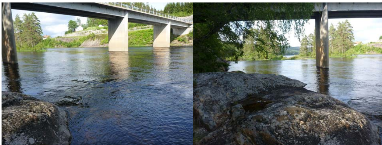
Figur 3.8 Mollestad bru, som treffer på Fv. 41 rett nedstrøms Flaksvatnet. Sett fra vestsiden av elva (venstre). Fjellformasjon nedstrøms det vestlige landkaret (høyre). Foto: J. Sauterleute
