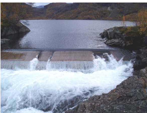
Dam sett østover (før rehabilitering)
