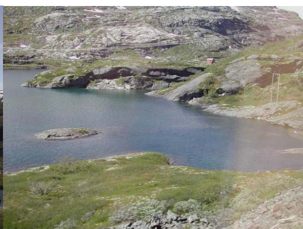
Klevavatn utløpsområdet, dam i høyre bildekant.
