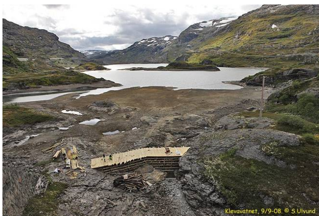
Rehabilitering av Klevadammen, nedtappet magasin
