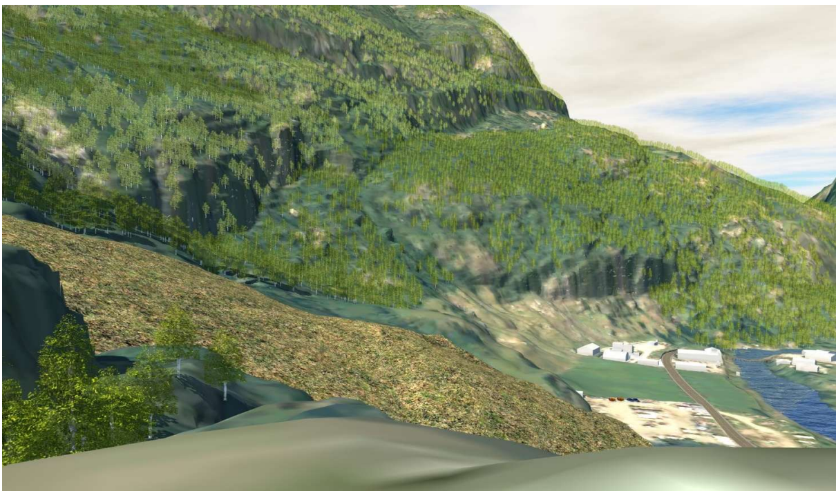
Figur 5-18 Tiltaket, Låvi 1, sett fra skyttarhuset mot nordvest.
