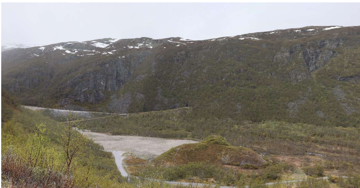
Figur 5-45 Fotostandpunkt 19 i kart, sett fra veien opp til Viddalsdammen.
