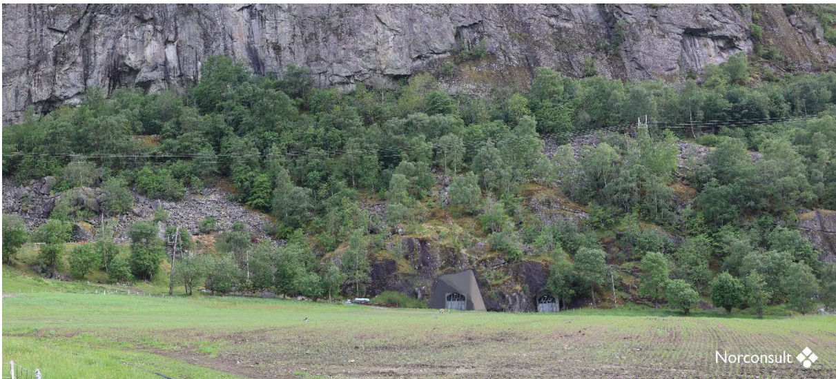
Figur 5-4 Nytt tverrslag til Låvi kraftverk bygges nært eksisterende tverrslag til Aurland 4. Fotostandpunkt 2 i kart.
