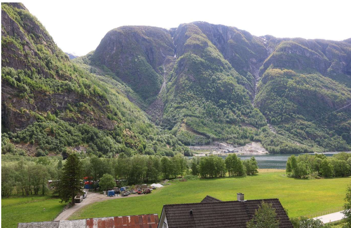
Figur 4-19 Delområdet sett fra Steine. Koblingsanlegget til Aurland 1 sees nederst i fjellsiden.
