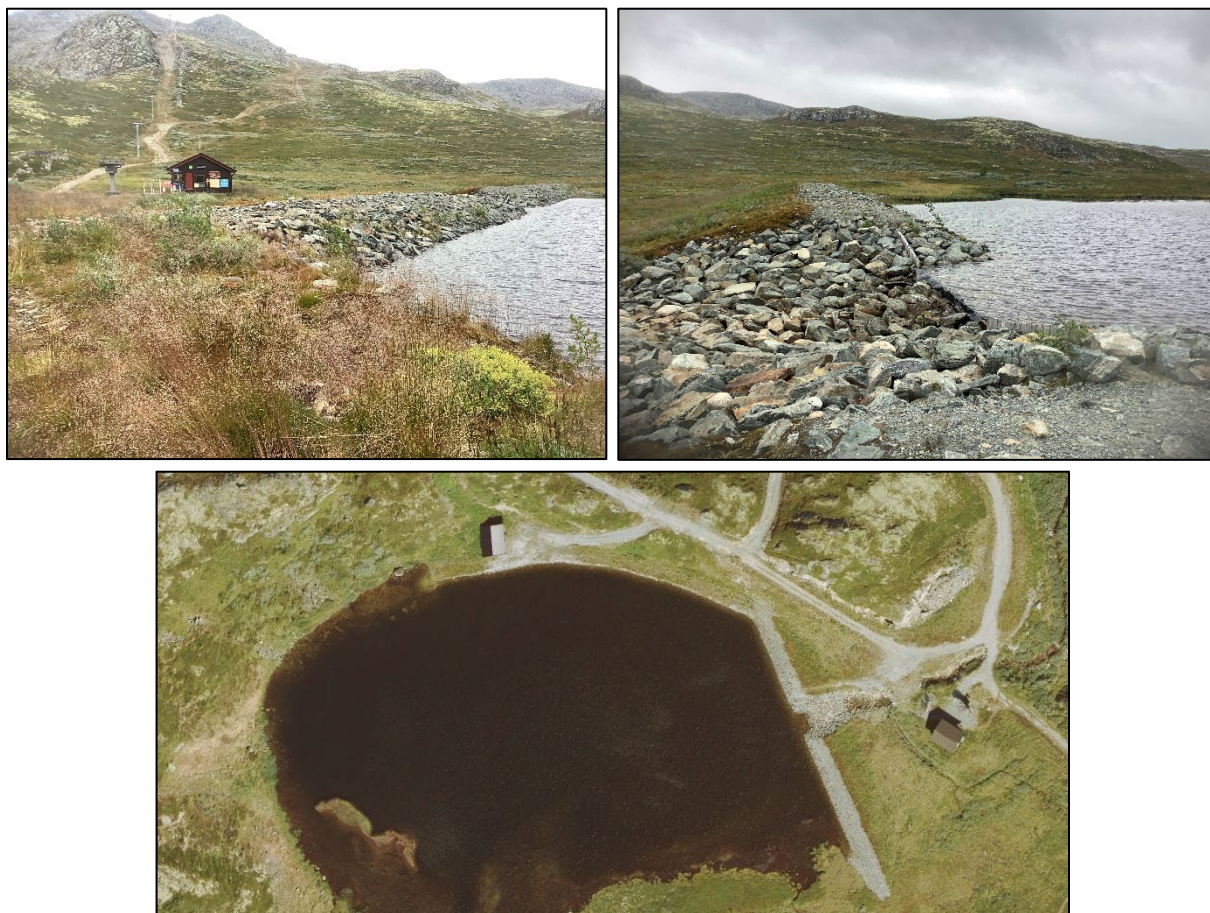
Figur 5. Beliggenhet og utforming av dam på bilder fra befaring (oppe) og flyfoto (nede).
