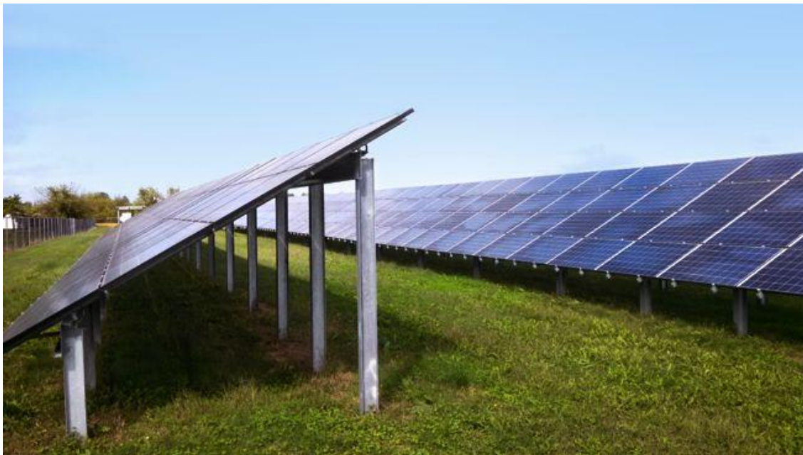
Figur 3-3: Eksempel på fast-vinkel installasjonsløsning (foto: Willowbrook Solar)
