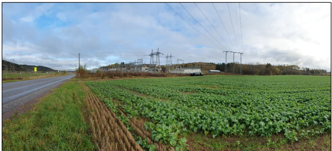
Figur 1.2 – Står syd i området (fig 1.1) og tar bilde mot transformatorstasjon i nordøst (Fra befaring den 24.10.2020)
