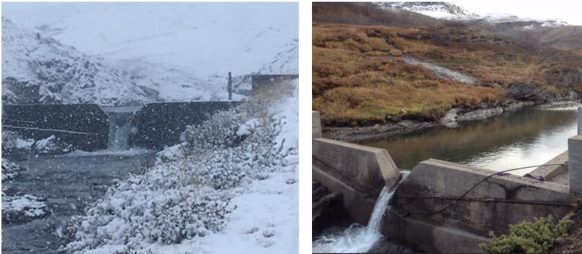
Figur 4. Måleprofil på stasjon Målset 70.8. Bilde: Statkraft Energi AS.
