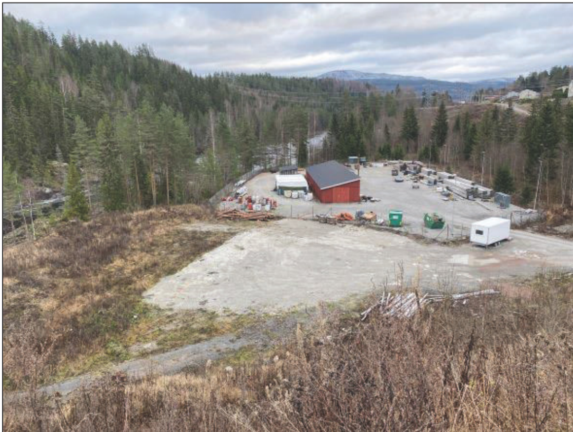
Figur 34 Eksisterende anleggsområde/lagerområde. Ny 132 kV kraftledning vil krysse området.
