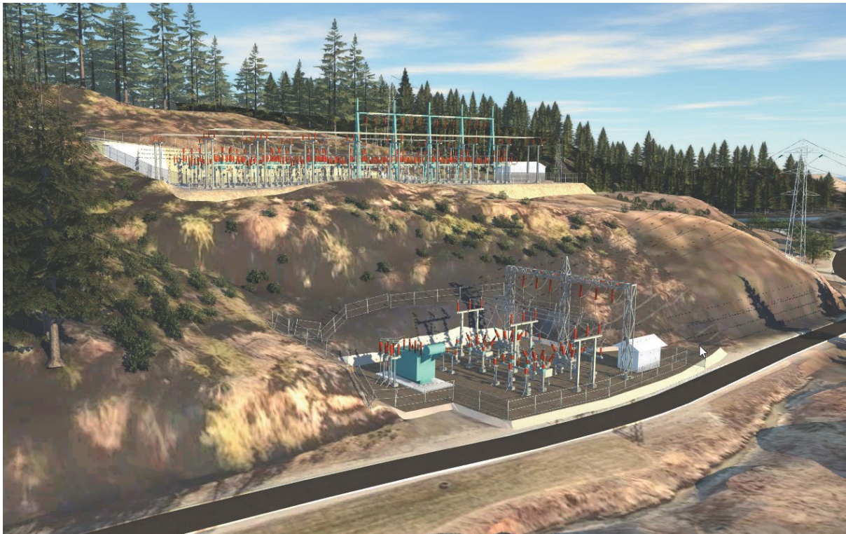
Figur 31 Modell av anlegget sett fra motsatt side av Mastedalen. Eksisterende Kaggefoss transformatorstasjon ses i forgrunnen. Modellen er ikke representativ med hensyn til vegetasjon som er tettere i virkeligheten.
