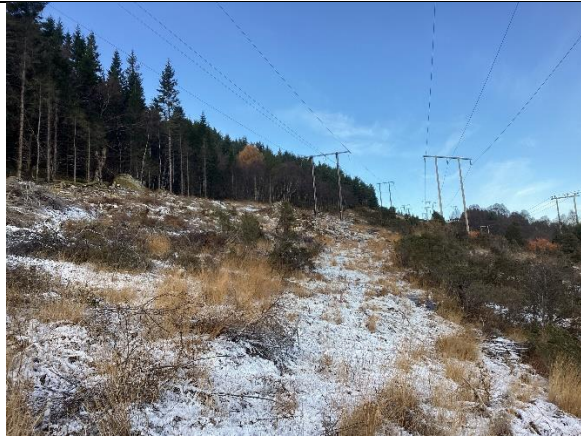
Figur 24 Frå sør mot mast 20 etter anleggsarbeid. Her er det køyrt, men det er lite spor
