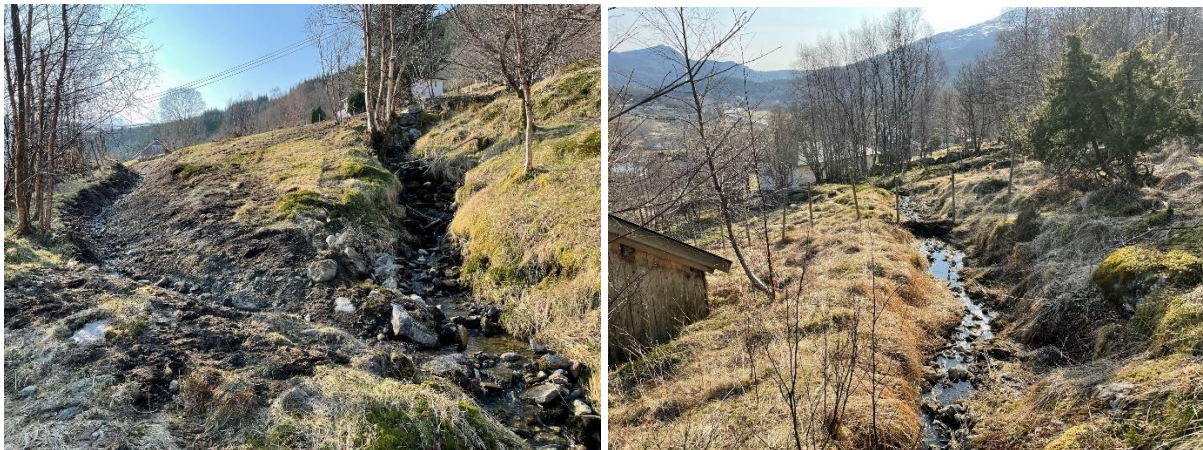
Figur 9 Nye og gamle grøfter i og rett overfor bebyggelsen
