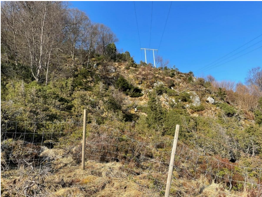
Figur 20 Terrengblokker i bratta opp mot nordre mast
