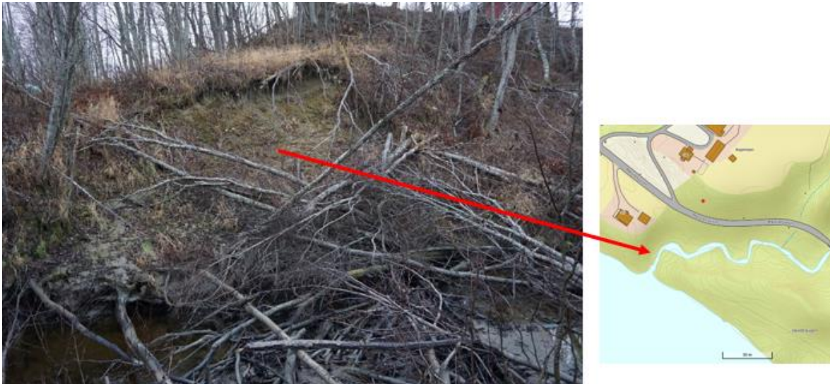
Figur 2. Fiskebekken, kraftig erosjon angitt i pilspiss
