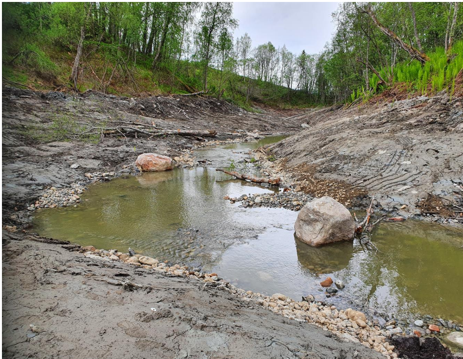
Figur 11. Ferdig sikringstiltak fra andre deler av Leirbekken i 2021
