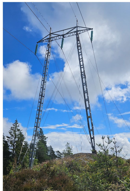
Figur 10: A) Mastetype (Portalmast av fagverk) som er tenkt for de nye mastene med planoppheeng. B) Dagens mastetype (Portalmast med intern og ekstern bardunering) på Bolvik - Rafnes og Herum - Frier.
