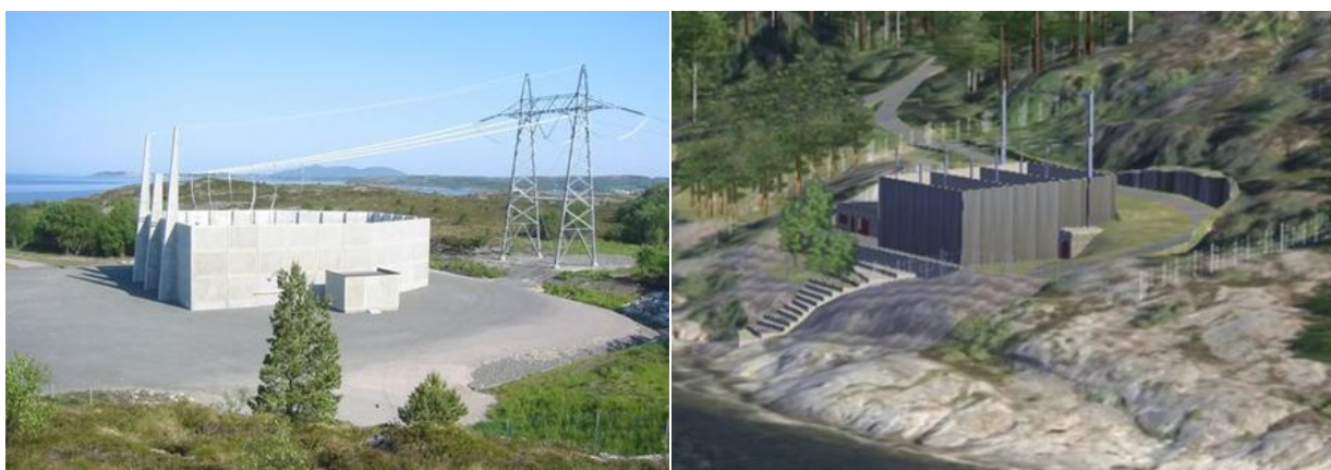
Figur 14: Eksempler på muffeanlegg for 420 kV kabler.
