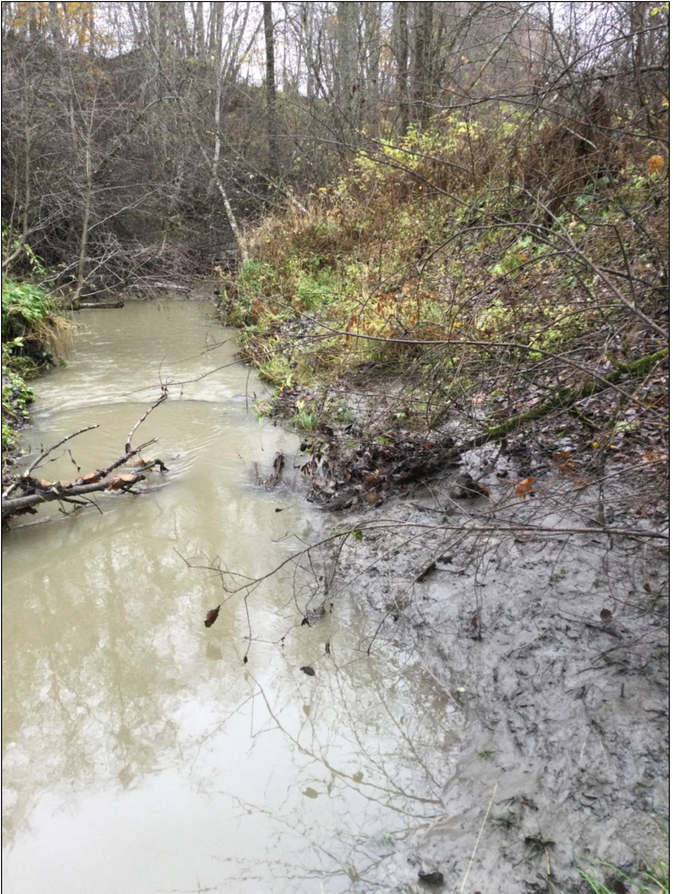
Bilde 20 (kraftig erosjon)
