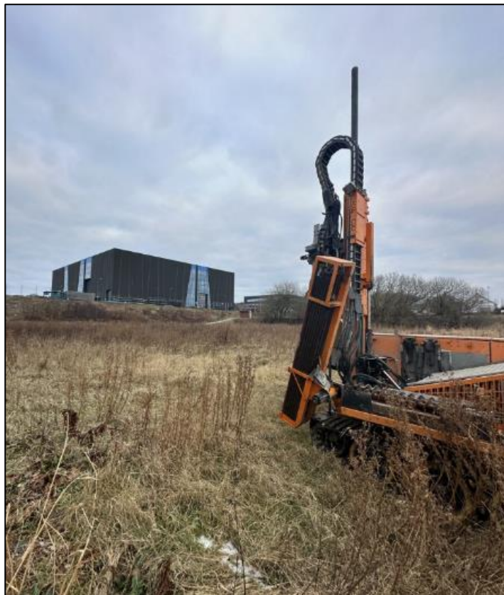
Figur 15: Borpunkt BP2s lokasjon.
