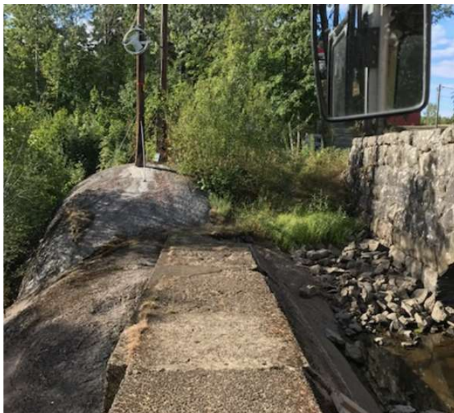
BILDE 4, BILDE AV FJELLKNAUS I DAMMENS SØRLIGE ENDE FØR 2018
