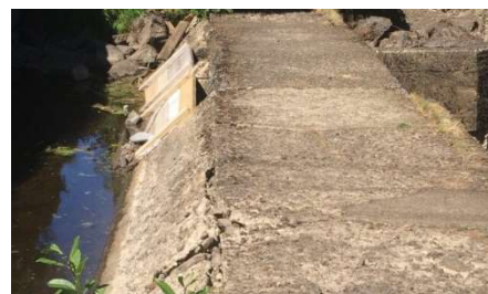
BILDE 2, DAMMEN FØR ARBEIDER 2018
