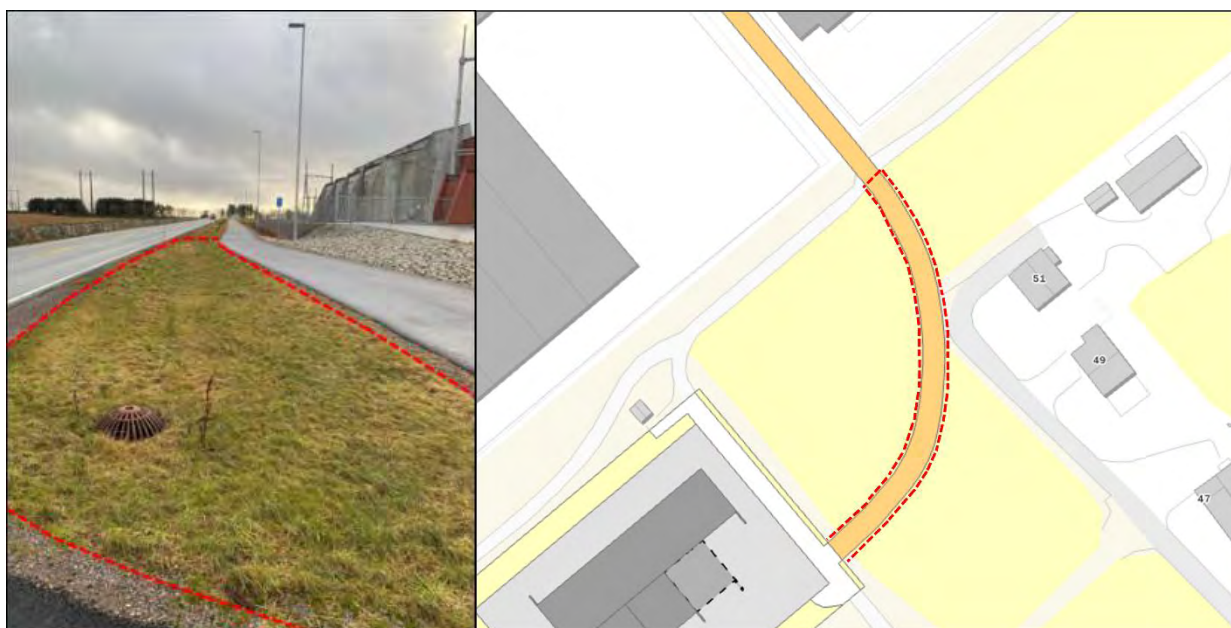
Figur 9 Bilde fra Opstad med gress over område tilrettelagt for spesialtransport (venstre) og område ved Tjora der gress over område for spesialtransport er aktuelt (høyre)
