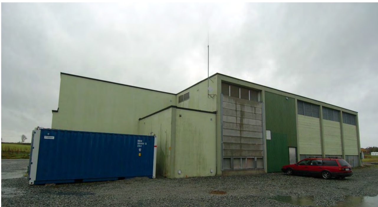
Figur 10 Eksisterende Risavika transformatorstasjon planlegges revet
