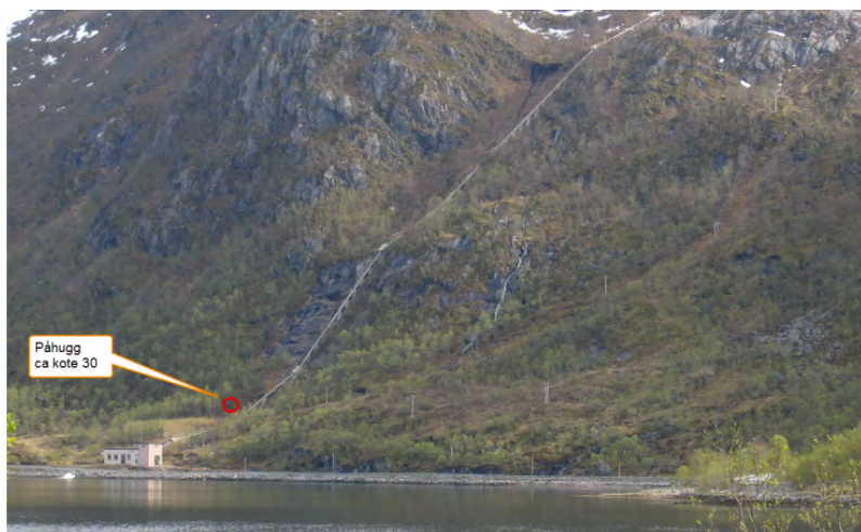
Figur 5: Bildet viser sted for påhugget til borehullet.
